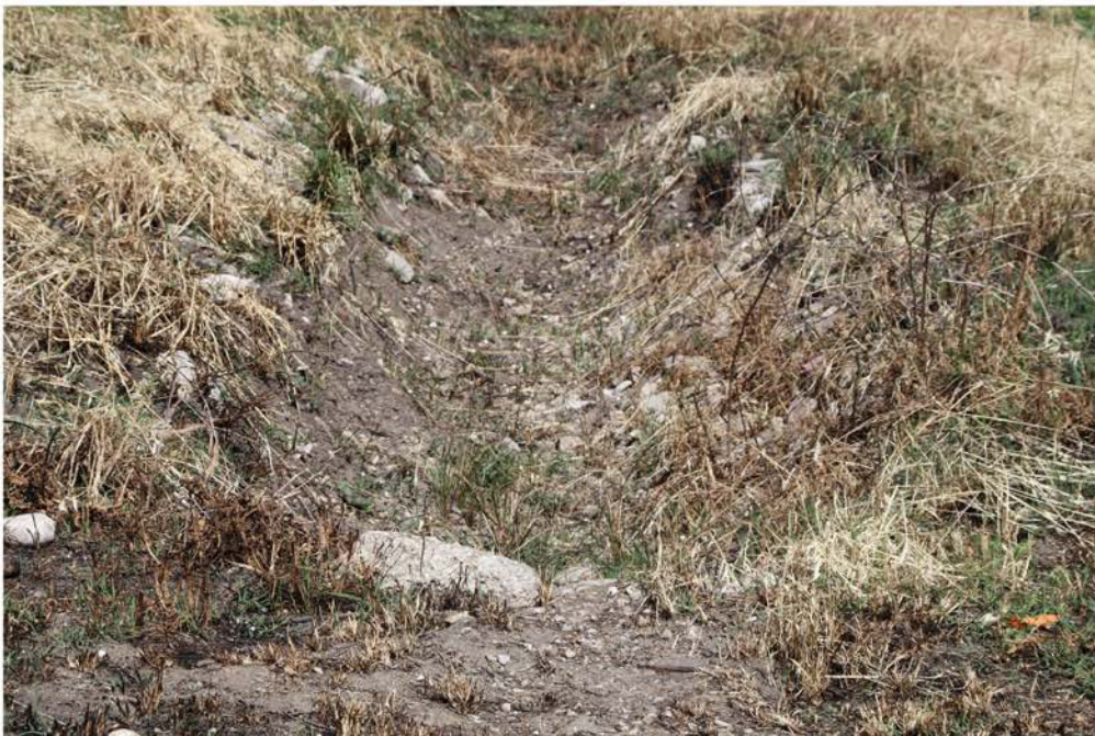
Candela FG_Piano Morto_Campo Ovest Lato S SS 655 (20).jpg
