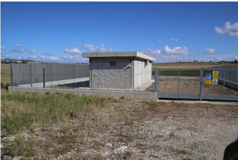
Candela FG_Piano Morto_cavidotto da CDS (1).jpg
