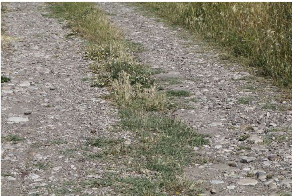
Candela FG_Piano Morto_Campo Ovest Lato S SS 655 (21).jpg
