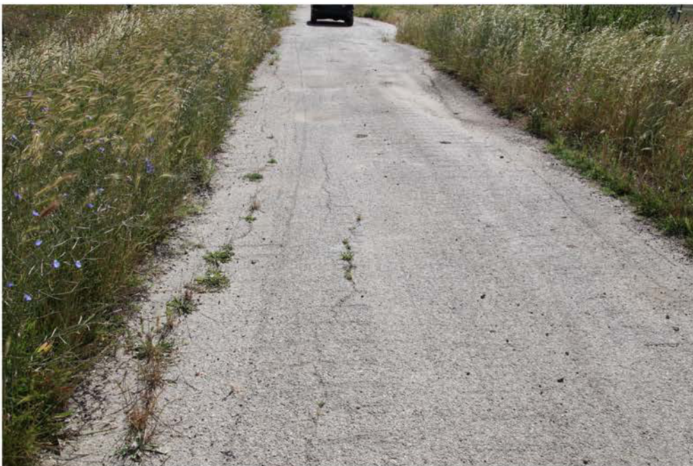
Candela FG_Piano Morto_cavidotto da CDS (12).jpg
