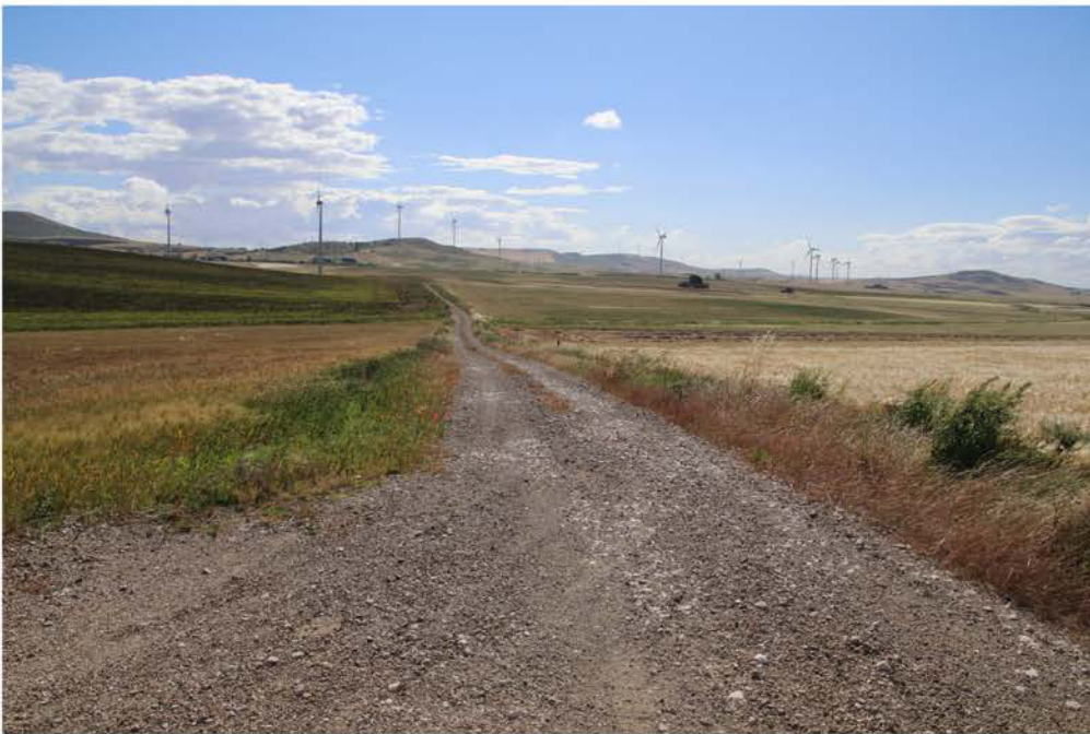
Candela FG_Piano Morto_cavidotto da CDS (4).jpg
