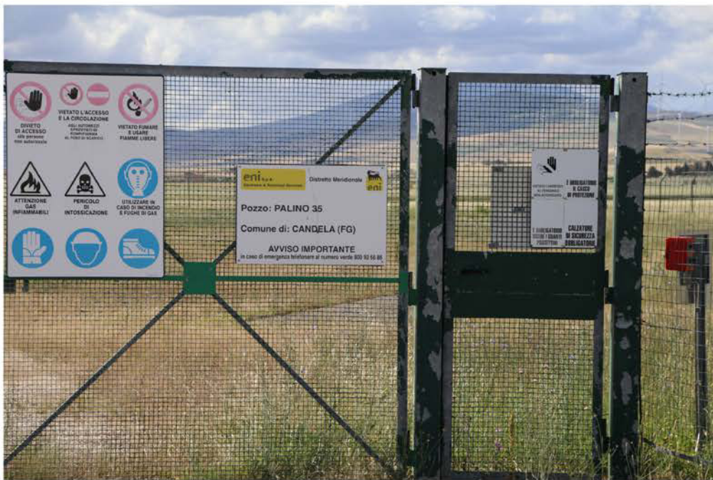
Candela FG_Piano Morto_cavidotto da CDS (16).jpg
