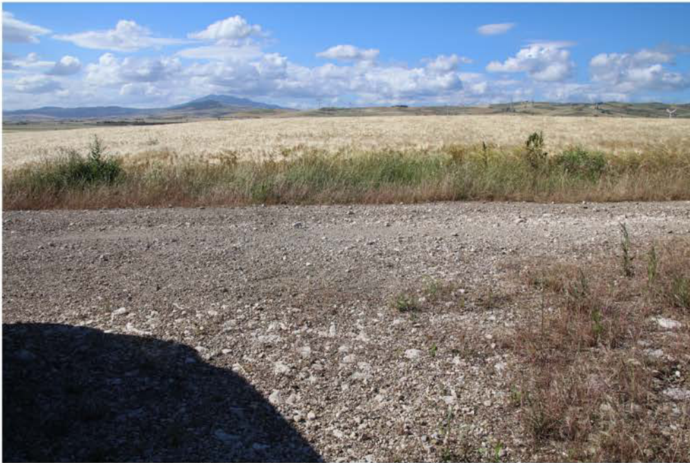
Candela FG_Piano Morto_cavidotto da CDS (2).jpg
