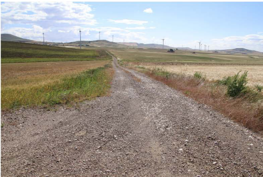
Candela FG_Piano Morto_cavidotto da CDS (3).jpg
