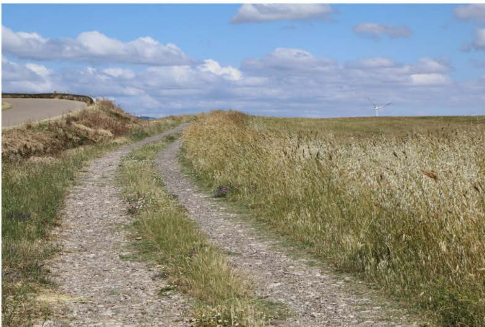
Candela FG_Piano Morto_Campo Ovest Lato S SS 655 (22).jpg
