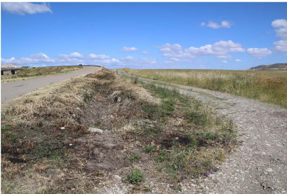
Candela FG_Piano Morto_Campo Ovest Lato S SS 655 (19).jpg
