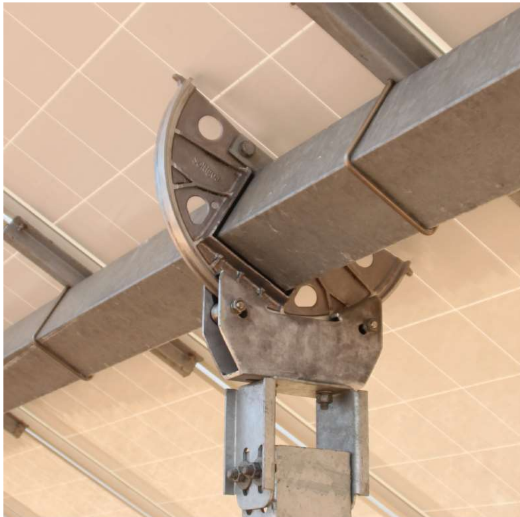
FIGURA 7: SCHEMA NODO TRAVE CONTINUA / COLONNA
