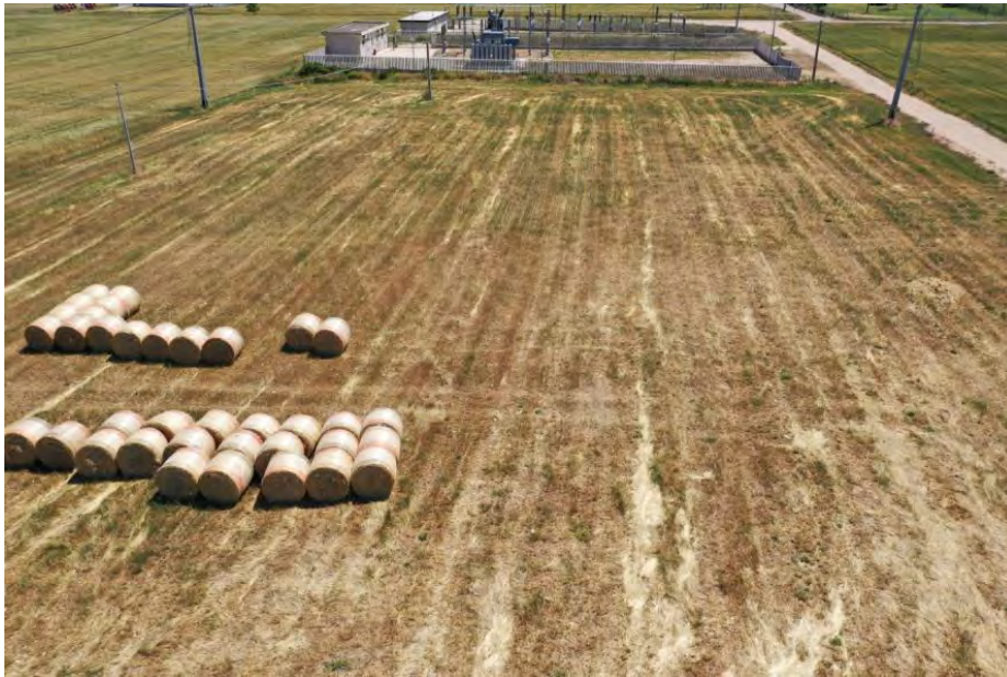
Figura 86. UR 3. Ripresa da drone da Nord
