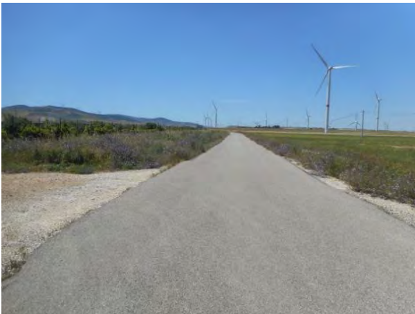
Figura 70 Tratto iniziale cavidotto MT di collegamento a SSE Renoir
