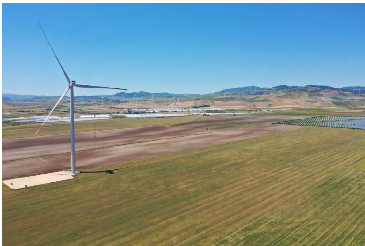
Figura 59 Ripresa da drone da Est
