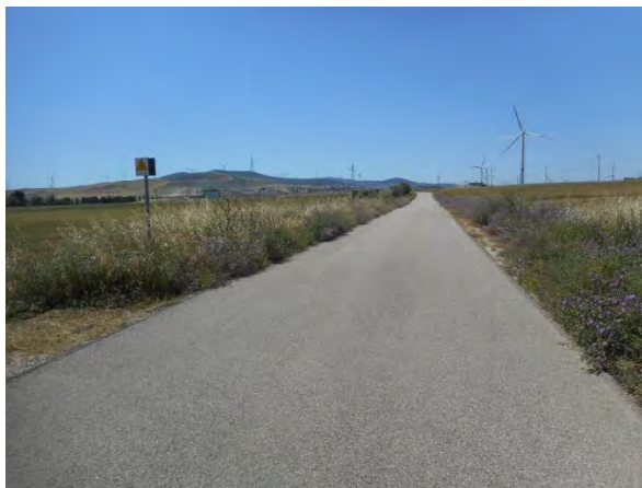
Figura 75 Tratto finale cavidotto MT di collegamento a SSE Renoir
