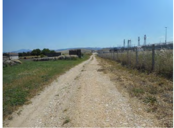
Figura 81 Tratto finale cavidotto AT su strada sterrata verso SSE Elce
