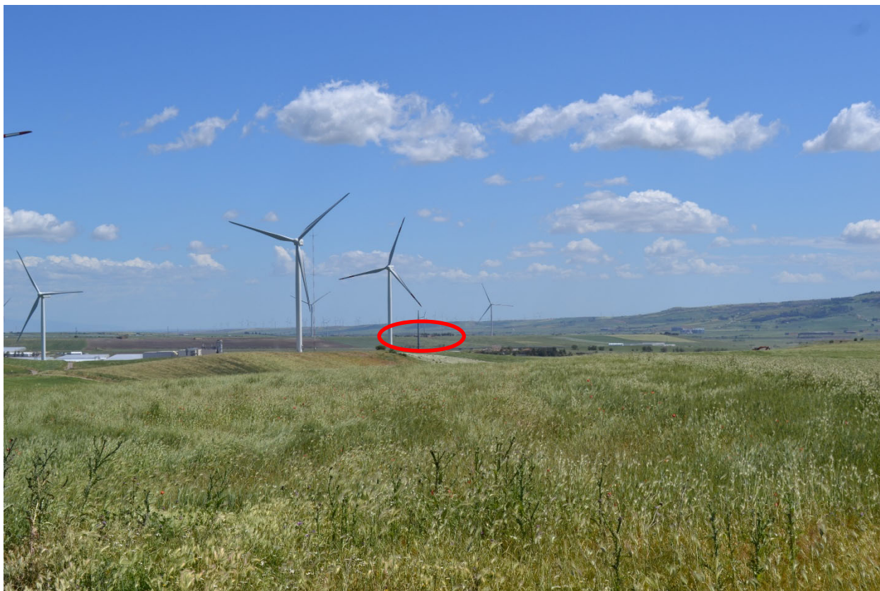
Ripresa fotografica da Masseria Viticone verso l'area dell'impianto in progetto cerchiata in rosso
