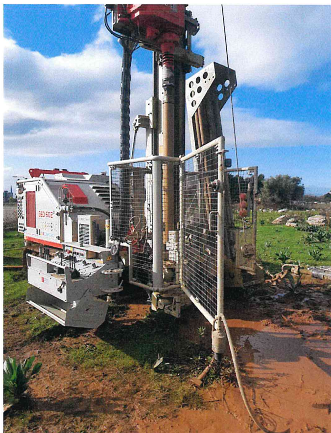
Esecuzione sondaggio geognostico a carotaggio continuo
