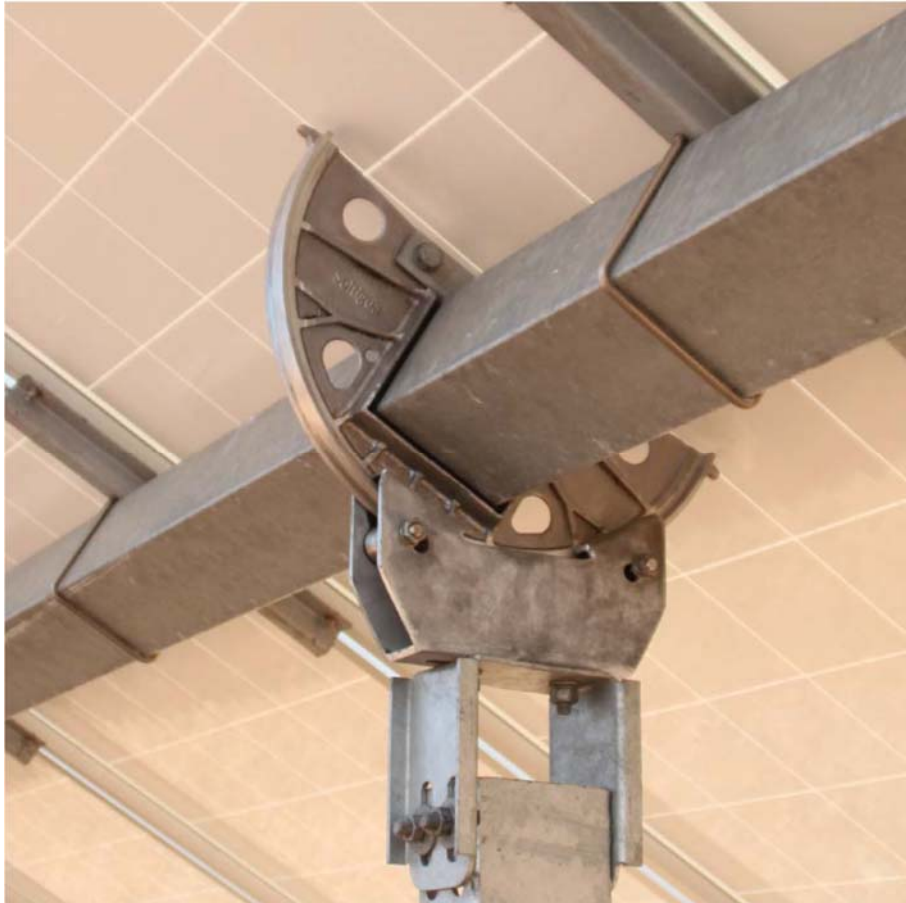
Schema nodo trave-pilastro
