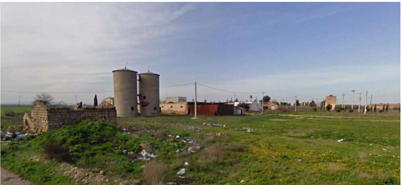
In alto, da sinistra: Masseria La vedova, ingresso a Pozzo terraneo. In basso: Pozzo Terraneo
