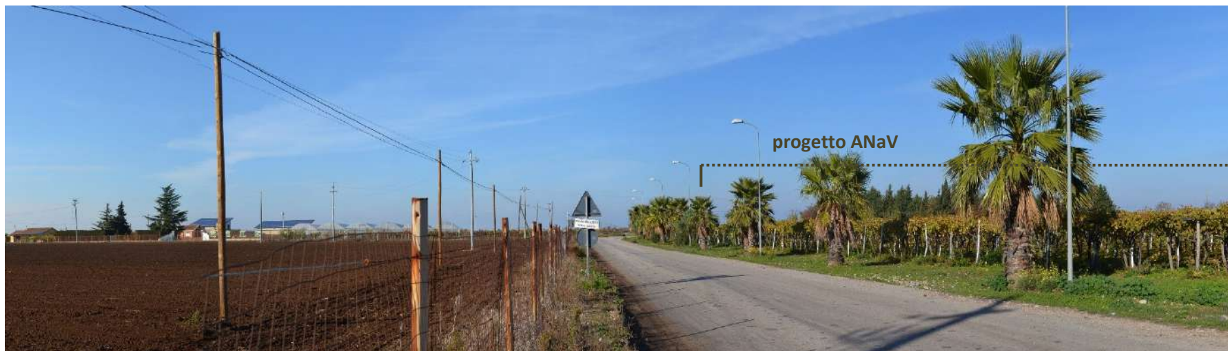
Panoramica – stato dei luoghi ex ante
