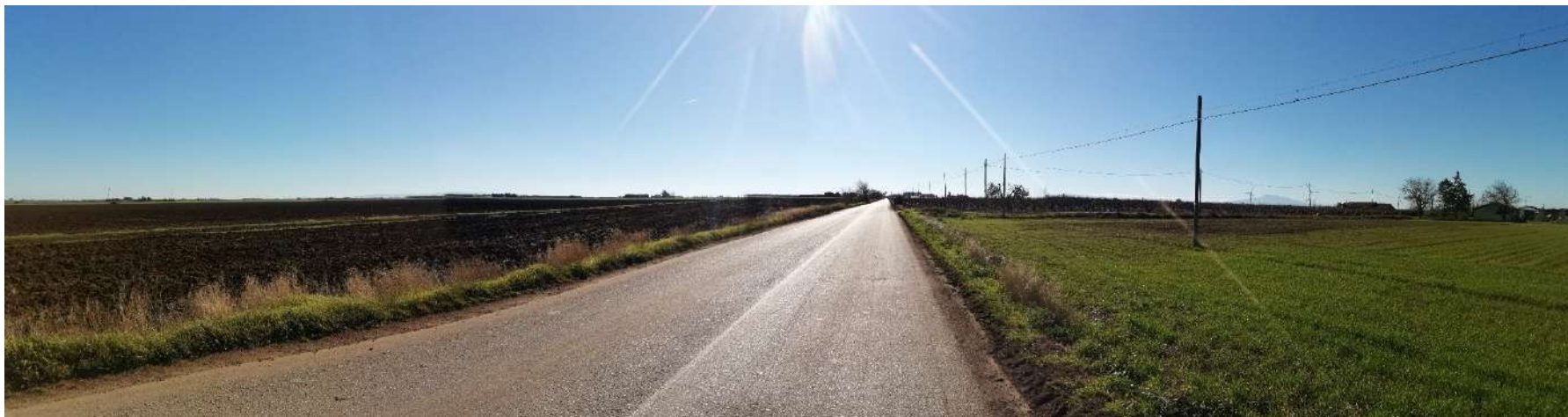
Panoramica – stato dei luoghi ex ante
