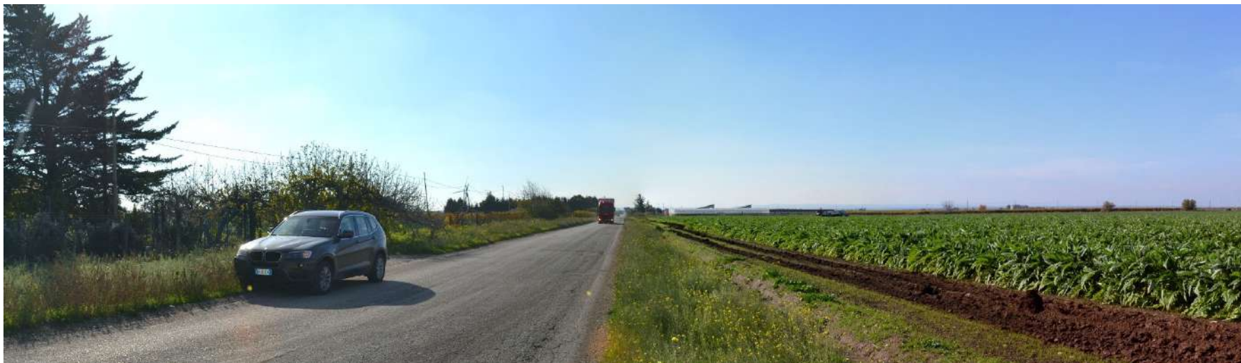
Panoramica – stato dei luoghi ex ante
