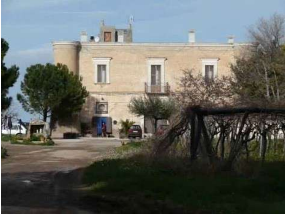
Masseria San Giovanni – stato attuale
