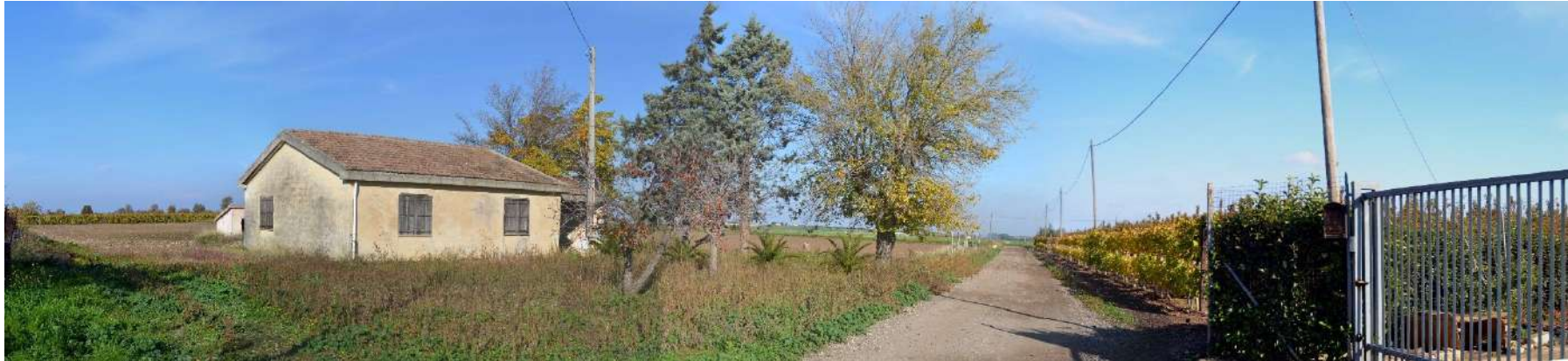
Panoramica – stato dei luoghi ex ante
