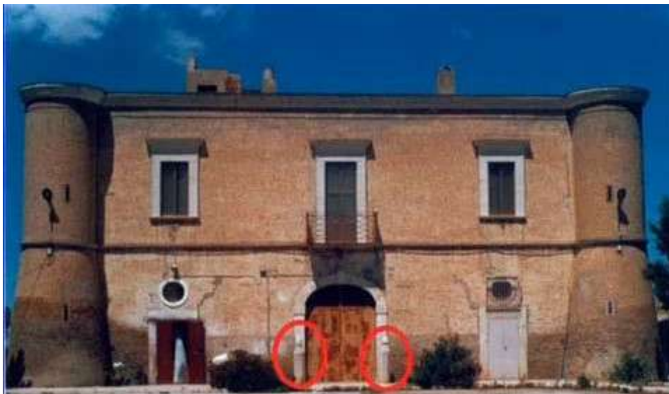
Masseria San Giovanni – dettaglio costruttivo attuale
