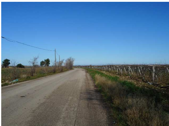
11- Località San Giovanni, tratto di cavidotto diretto a NNW visto da SSE.
