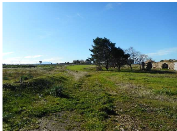
12 - Località San Giovanni, tratto di cavidotto diretto a NNW visto da SSE.
