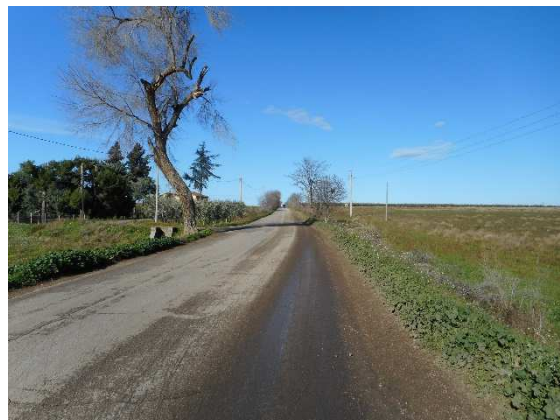
14 - Masseria Graziani, tratto di cavidotto diretto a NNW visto da SSE.
