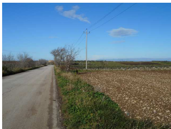
15 - Località Graziani-San Giovanni dei Fiori, tratto di cavidotto diretto a NNW visto da SSE.
