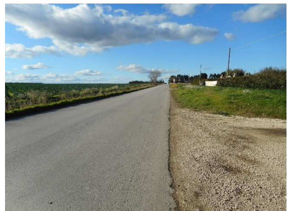
28 - Masseria Petrone-Strada Provinciale 83, tratto di cavidotto diretto a NW visto da SE.
