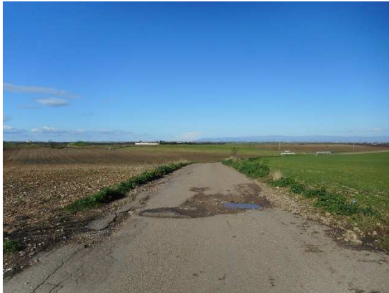
23 - Località Gavitella-Località Pozzelle, tratto di cavidotto diretto a N visto da S.
