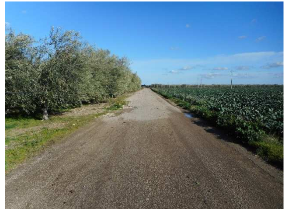
26 - Località Tre Confini, tratto di cavidotto diretto a ENE visto da WSW.
