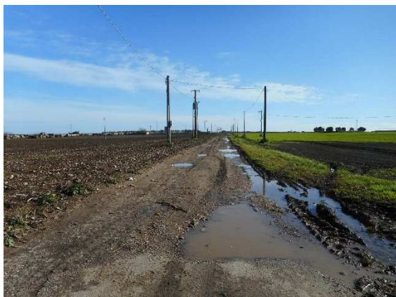
21 - C. Gavitella-Località Pozzelle, tratto di cavidotto proveniente da a SE visto da NW.
