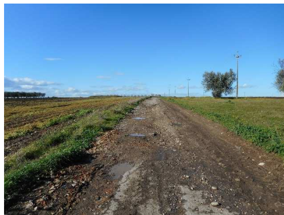
20 - Località Porcareccia, tratto di cavidotto diretto a NW visto da SE.
