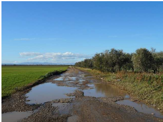
17 - Località Pozzelle, tratto di cavidotto diretto a WSW visto da ENE.
