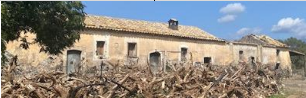
R11 - Edificio rurale non abitato
