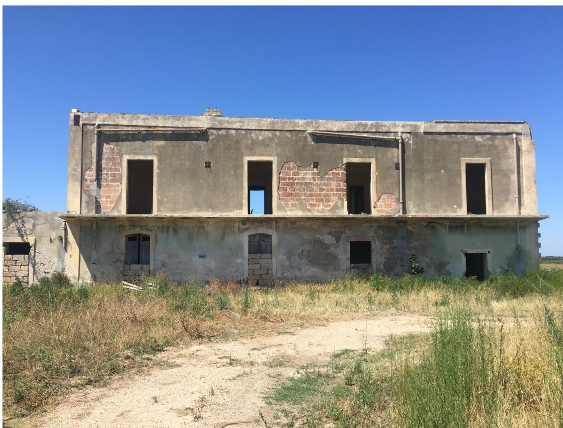
Figura 12 - L'edificio collabente interno alla recinzione di impianto
