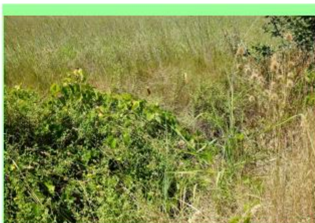
Figura 17: Canale occultato dalla vegetazione (Punto rilievo: 29).
