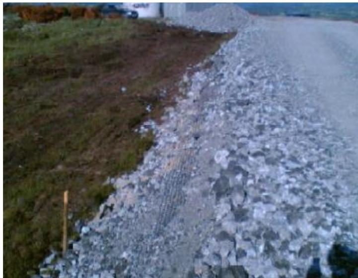
Figura 37 Superficie stradale in misto stabilizzato e drenaggio
