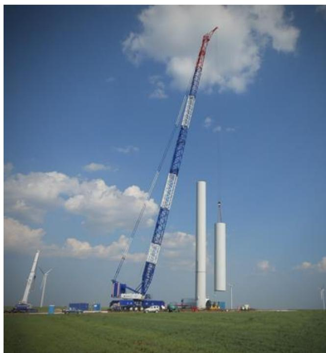
Figura 42 Sollevamento, posizionamento e fissaggio dei tronconi intermedi
