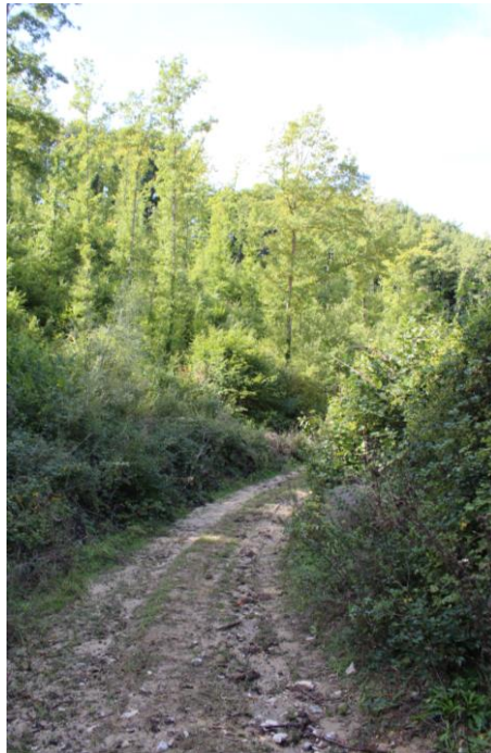
Figura 11 Tratto 2 strada da adeguare
