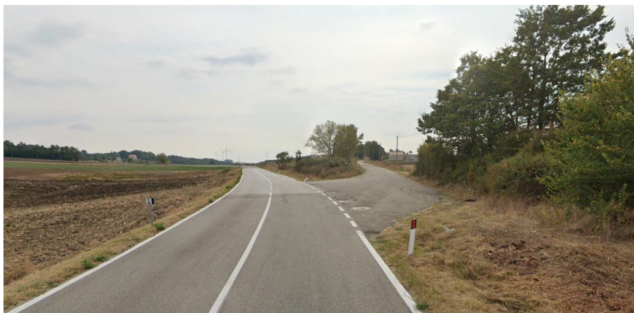
Figura 5 svincolo di accesso al tronco 1
