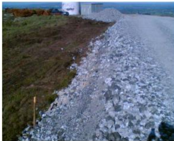
Figura 19 - Tipologia di nuova viabilità in misto stabilizzato
