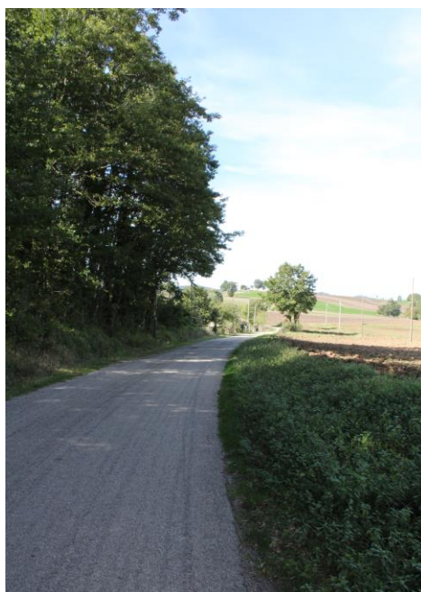
Figura 10 tratto B, strada da adeguare
