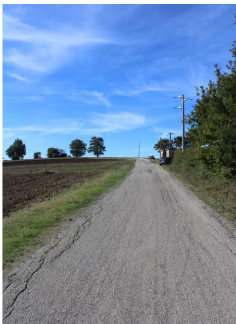
Figura 9 tratto A, strada da adeguare
