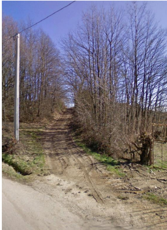
Figura 13 tratto 6 strada da adeguare
