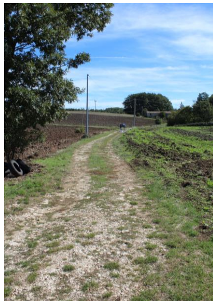
Figura 12 tratto 3 strada da adeguare
