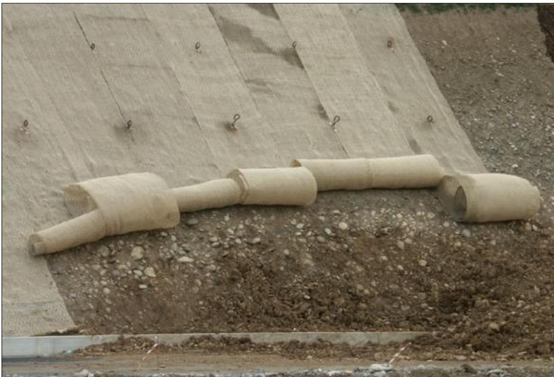
Figura 6 - Esempio di rivestimento in geostuoia
