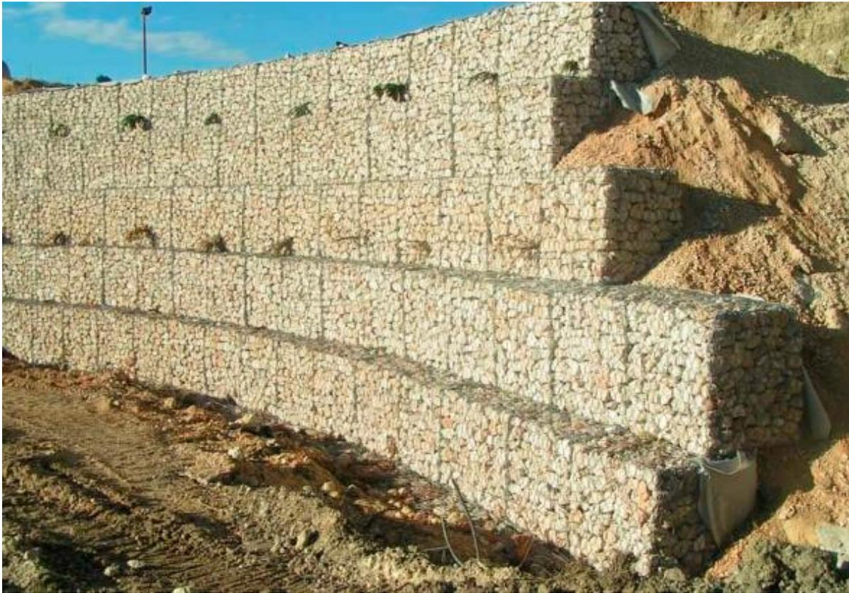
Figura 8 - Esempio di gabbionate rinverdite
