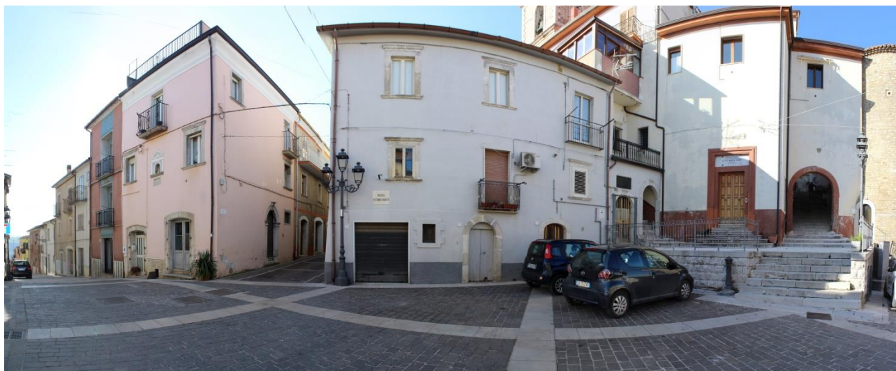
Figura 31 Panoramica ex ante/ex post Torre
