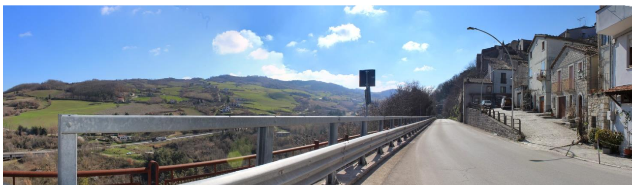
Figura 45 Panoramica ex ante, ex post Torre
