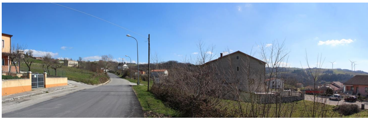
Figura 20 Panoramica ex ante, ex post, punto esterno centro abitato Castelpagano
