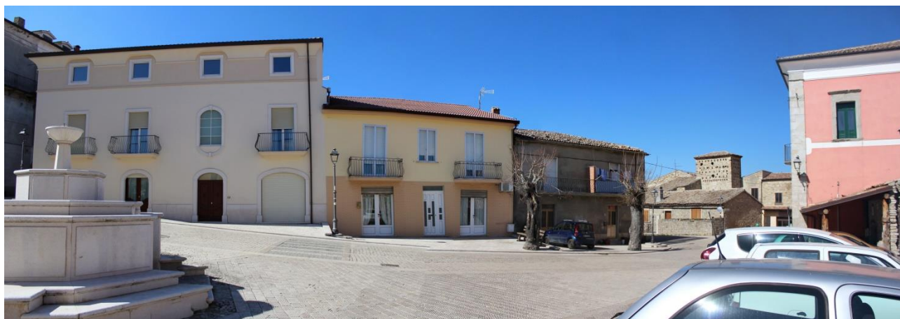
Figura 34 Panoramica ex ante/ex post Palazzo Lembo e Chiesa di S. Antonio
