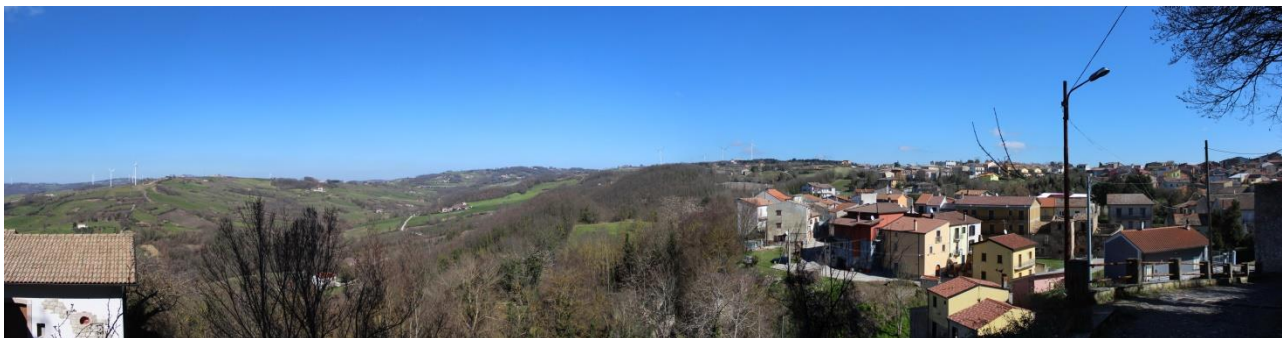
Figura 24 Panoramica ex ante palazzo Monumentale, Colle Sannita
