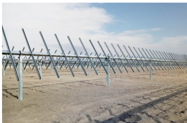
Rappresentazione della struttura di supporto – vista frontale
