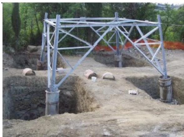
Esempio di fondazione – fonte - Terna
