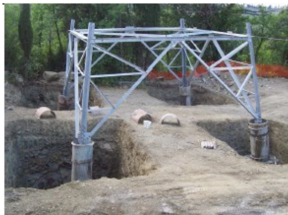
Esempio di fondazione – fonte - Terna
