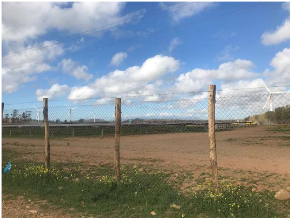
Figure 3-14. Tipologia di recinzione utilizzata
