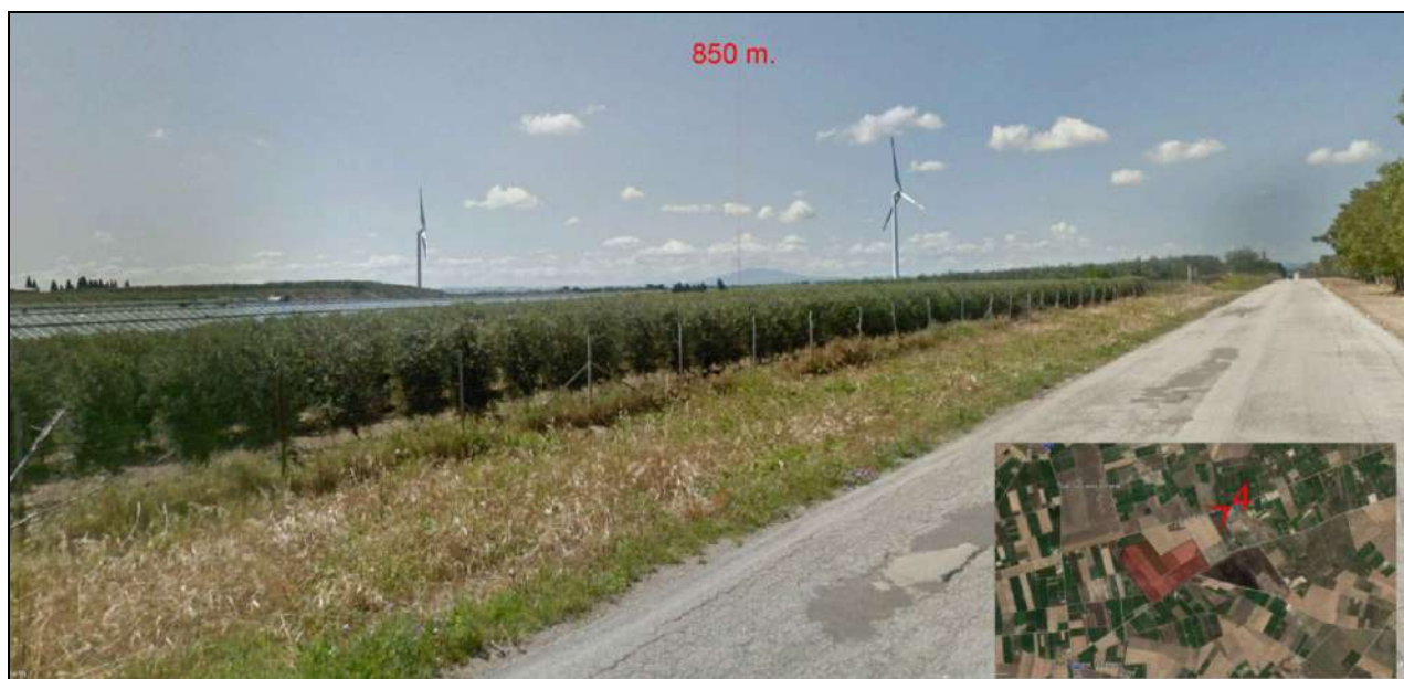
Foto 8. SP 95 Cerignola –Candela: Le ostruzioni antropiche schermano totalmente l'area d'intervento (esempio di fotoinserimento tratto dall'elaborato: CDD70K7_4.3.6_Relazione Paesaggistica)
