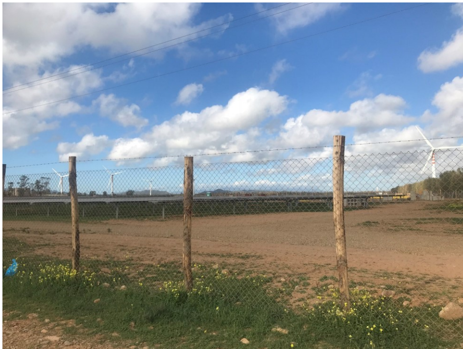
Figure 1-14. Tipologia di recinzione utilizzata
