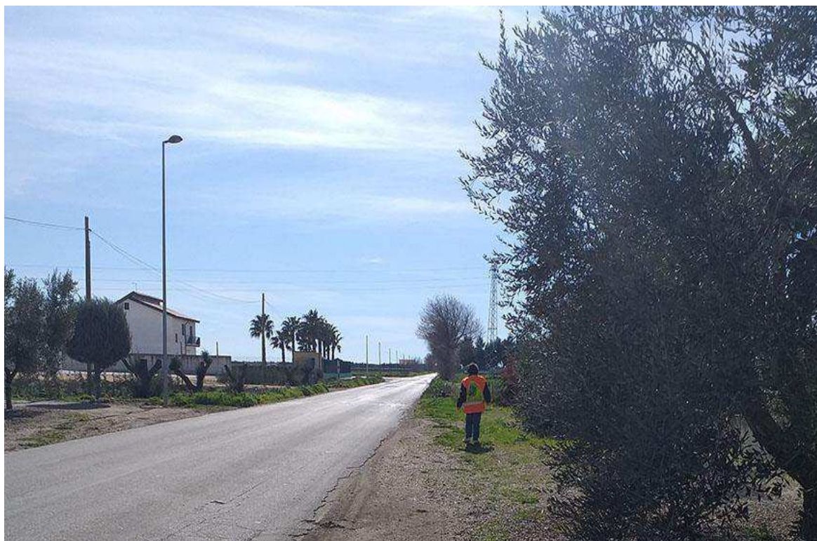
37 – Stornara (FG), UR 5, panoramica del segmento di cavidotto corrente su SP 83 periferia S del centro abitato
