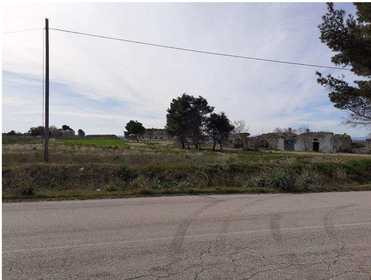
Cerignola (FG), località San Giovanni in Fonte, segmento del cavidotto in corrispondenza della segnalazione architettonica e archeologica
