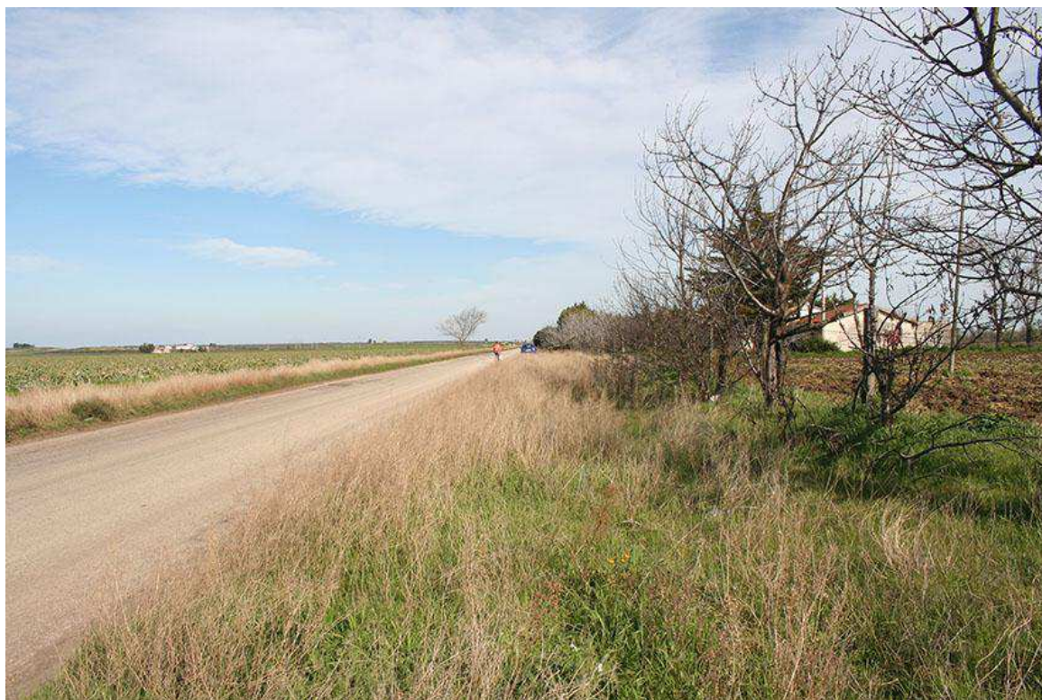
23 – Cerignola (FG), loc. Canale Gentile, UR 3, segmento di cavidotto corrente su SP 95
