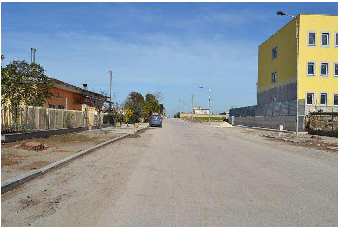
Stornara (FG) periferia nord del centro abitato, UR 5, via La Menola, area interessata dall'attraversamento di un segmento del cavidotto
