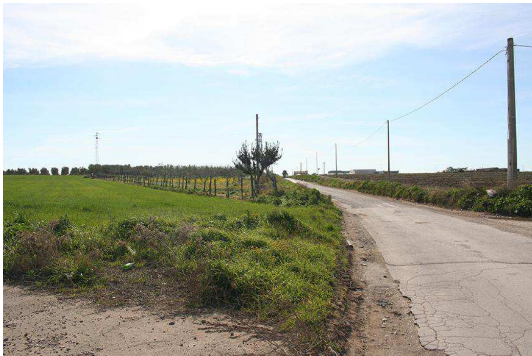
Stornara (FG), via La Menola, UR 6 a N di Mass. Moscarella, tratto in cui il piano di campagna è al di sopra del piano stradale
