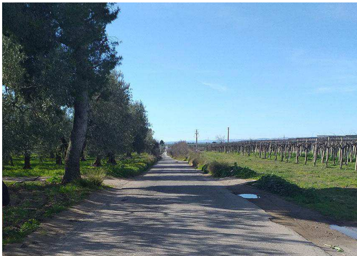
45 – Stornara (FG), UR 6, panoramica dell'ultimo segmento di cavidotto corrente su S.V. Schiavone
