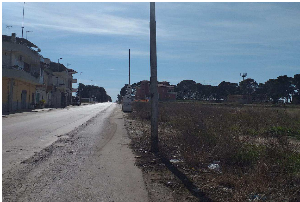
38 – Stornara (FG), UR 5, panoramica del segmento di cavidotto corrente su via Tenente Maggiore Vincenzo
