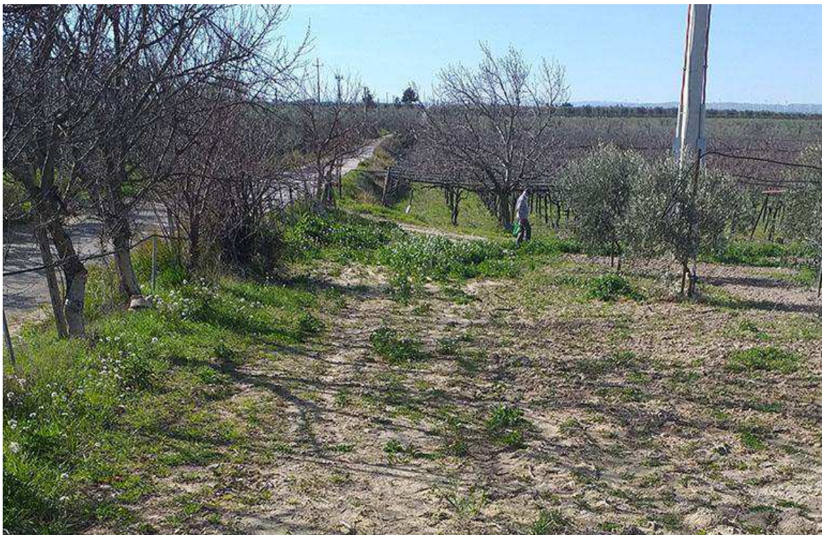
44 – Stornara (FG), UR 6, panoramica del segmento di cavidotto corrente su S.V. Schiavone
