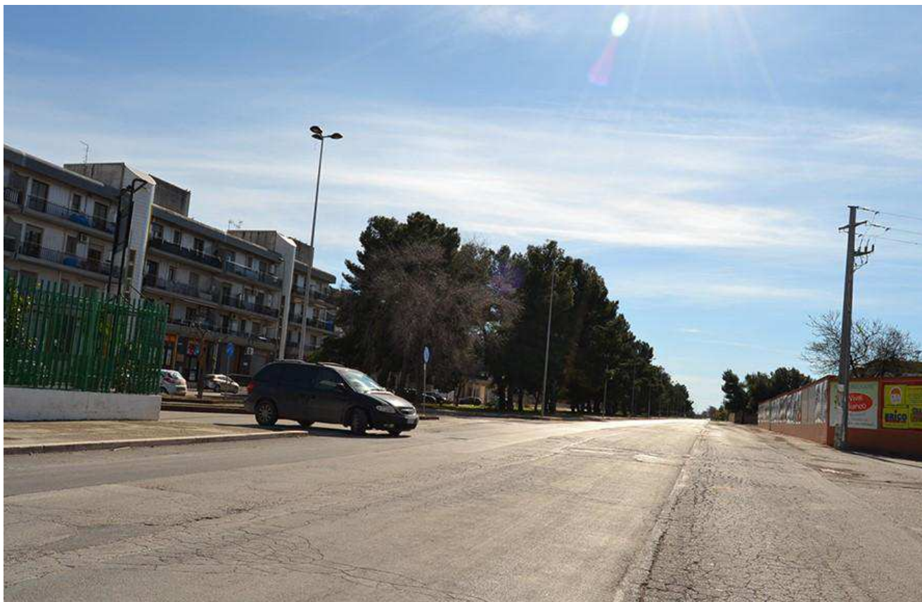
Stornara (FG), panoramica di parte del primo segmento dell'UR 5 su via Tenente Vincenzo Maggiore
