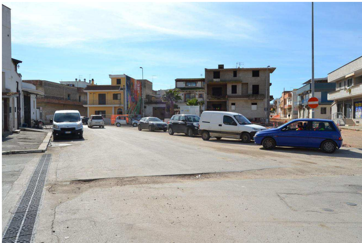
39 – Stornara (FG), UR 5, segmento di cavidotto corrente su strade della periferia N del centro abitato
