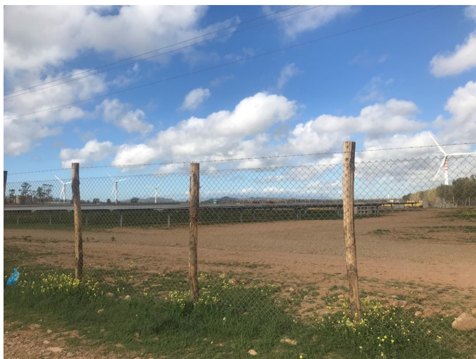
Figure 3-13. Tipologia di recinzione utilizzata
