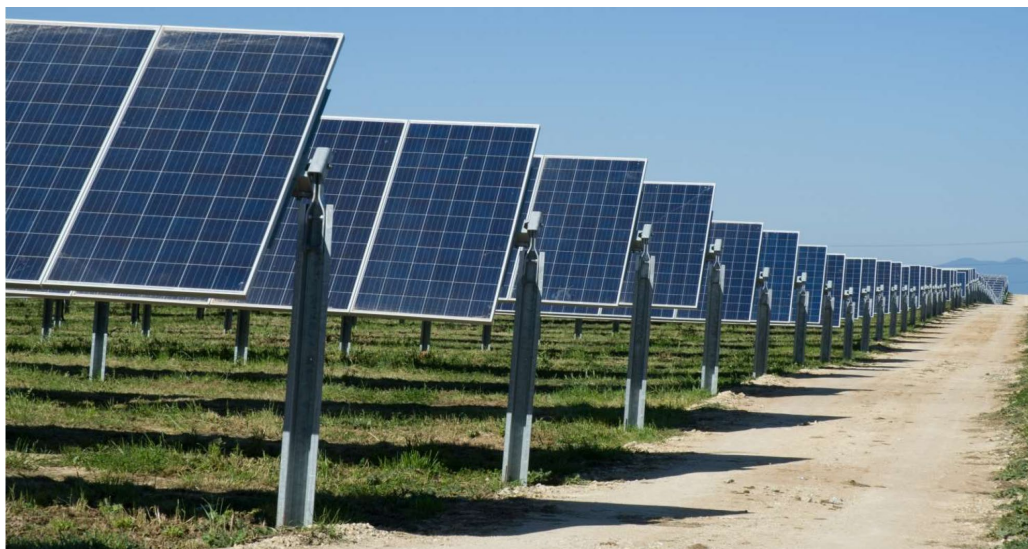
Figura 10 – Stato del cantiere al termine dei lavori
