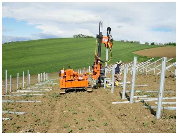
Figura 9 - Posa strutture metalliche di fondazione
