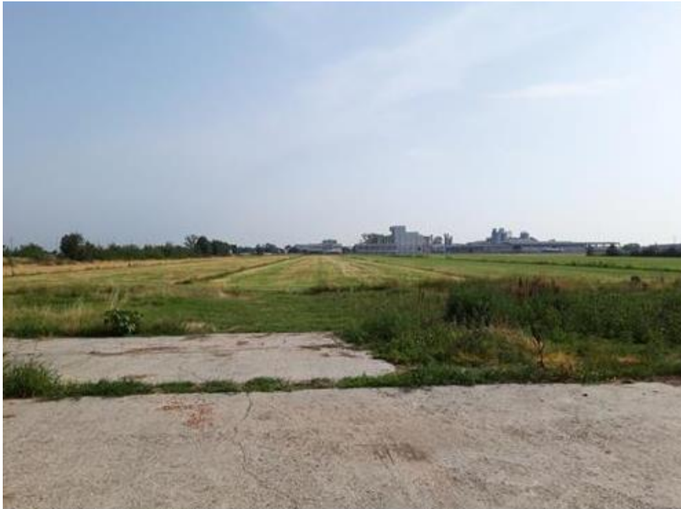
Figura 6 - Vista area oggetto di studio da sud
