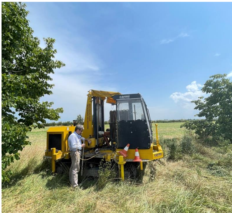
Figura 5-2 - Mezzo utilizzato per le prove CPTe
