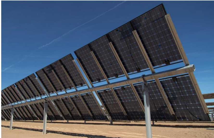
Figura 5: Esempio di struttura + modulo FV bifacciale
