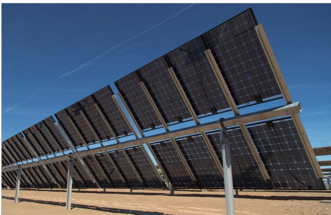
Figura III.5- Esempio struttura + modulo FV bifacciale
