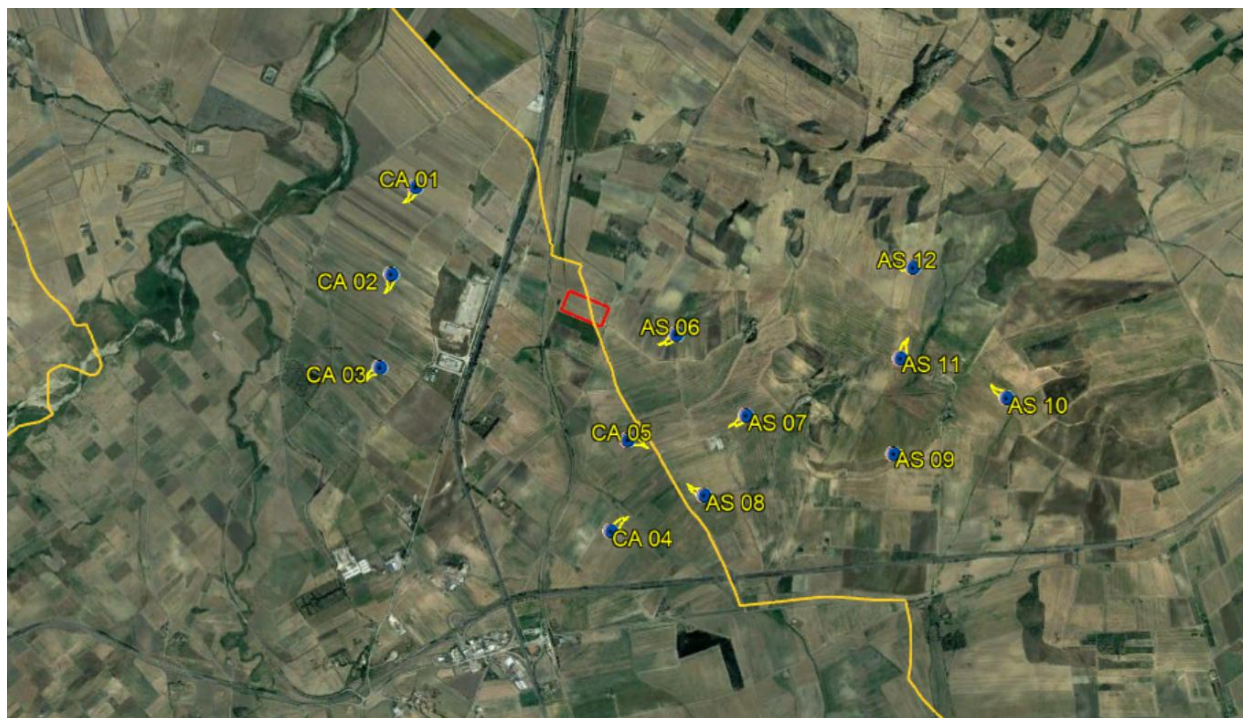
Figura 6 - Stralcio dell'impianto e di una potenziale area per la realizzazione del progetto "Oasi della biodiversità" (in rosso)
