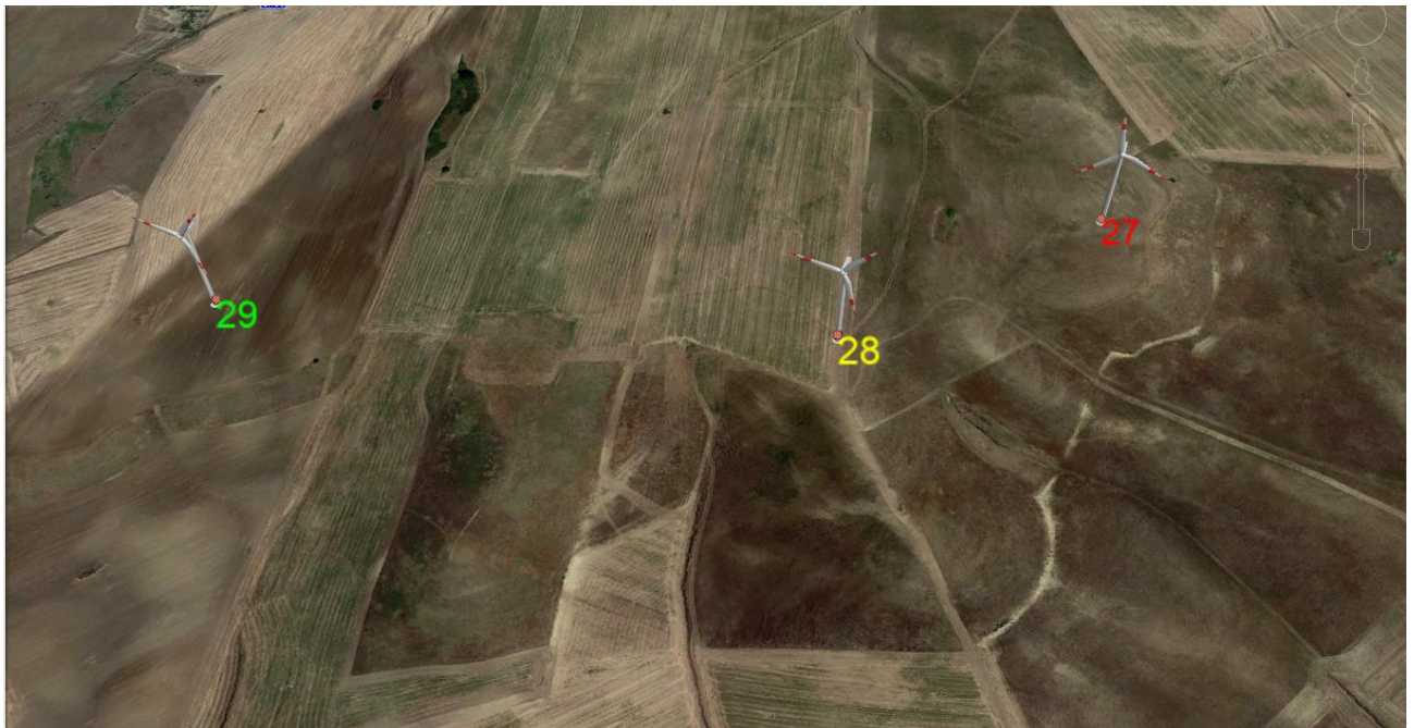
Figura 18 Foto inserimento Turbine 27,28,29 non installate ancora
