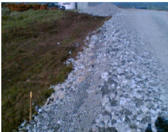
Figura 11: Superficie stradale in misto stabilizzato e drenaggio
