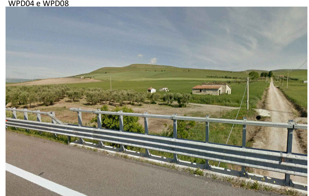
Foto 15) Area destinata all'adeguamento stradale e alla nuova realizzazione
