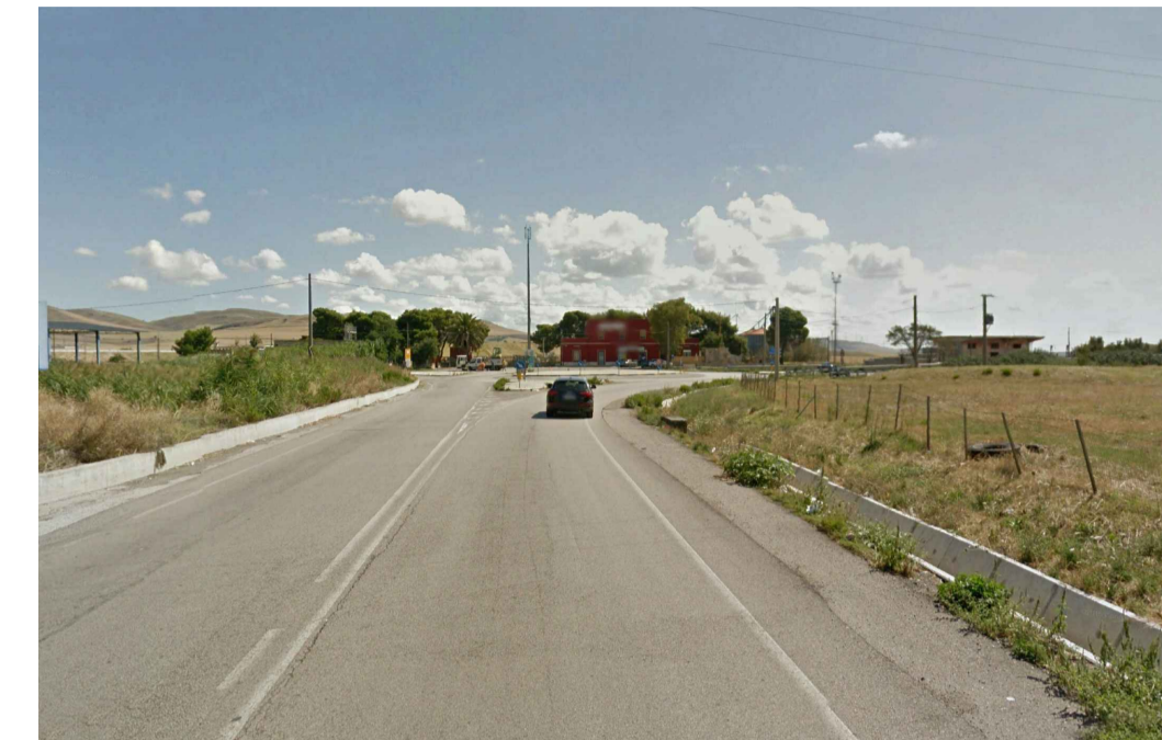
Foto 4) Svincolo per l'immissione in strada statale n. 655
