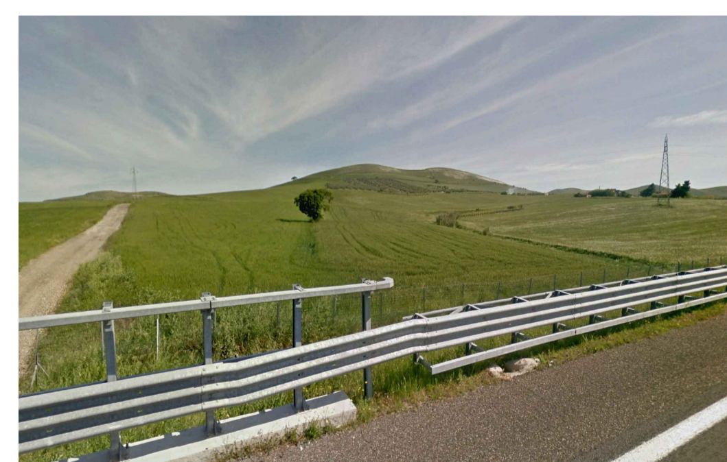
Foto 14) Area destinata all'adeguamento stradale e alla nuova realizzazione
