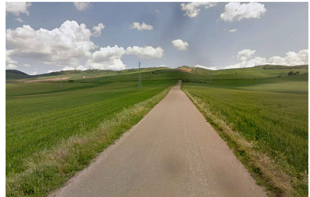
Foto 9) Vista su area interessata dalla realizzazione di una nuova strada
