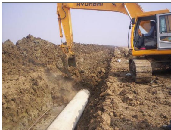
Figura 2—H: Rinterro della condotta
