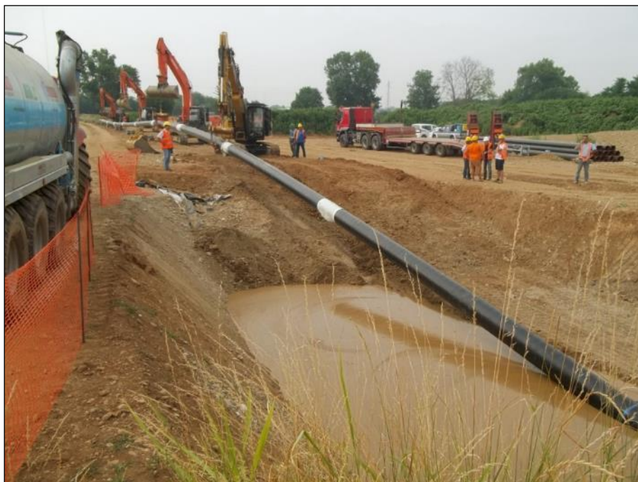
Figura 2—O: Esempio di operazione di varo della TOC
