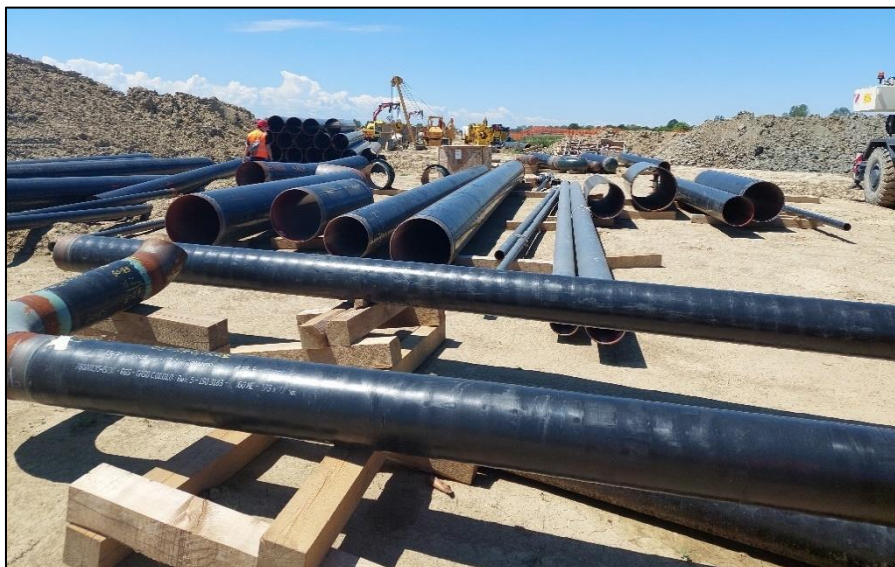
Figura 2—D: Piazzola di accatastamento tubazioni
