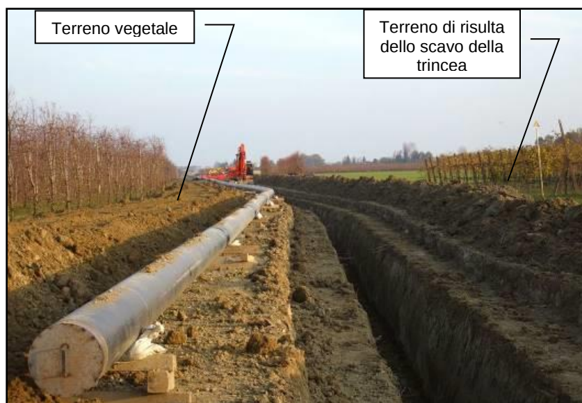
Figura 7—B: Fascia di lavoro durante le operazioni di scavo con i relativi cumoli di humus e terreno
