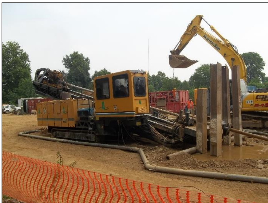
Figura 2—N: Esempio di Rig di perforazione
