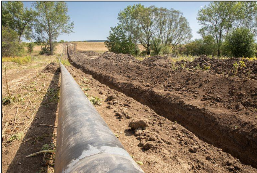
Figura 2—C: Scavo della trincea
