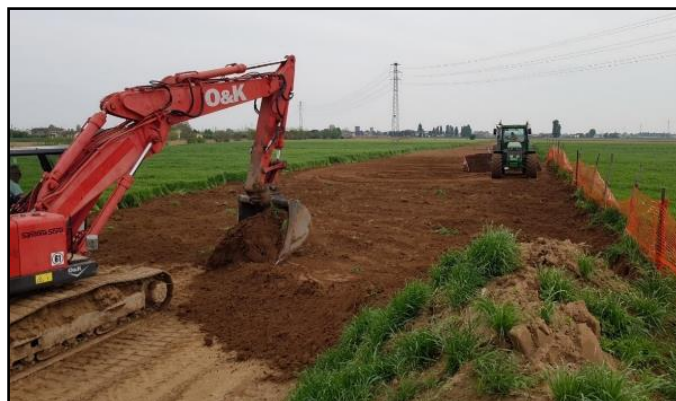
Figura 2—I: Distribuzione dello strato humico superficiale
