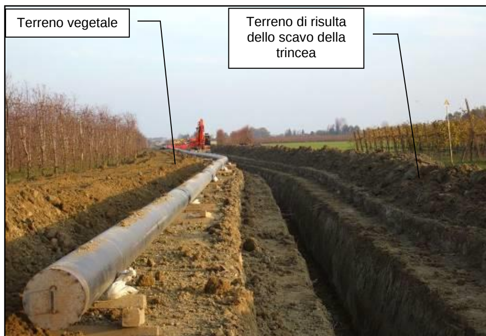
Figura 2—G: Scavo della trincea
