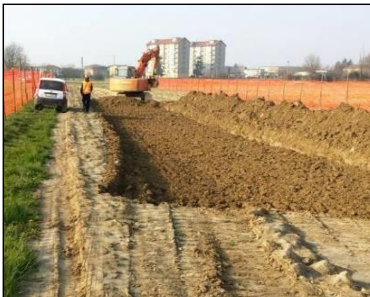
Figura 2—E: Apertura della pista di lavoro
