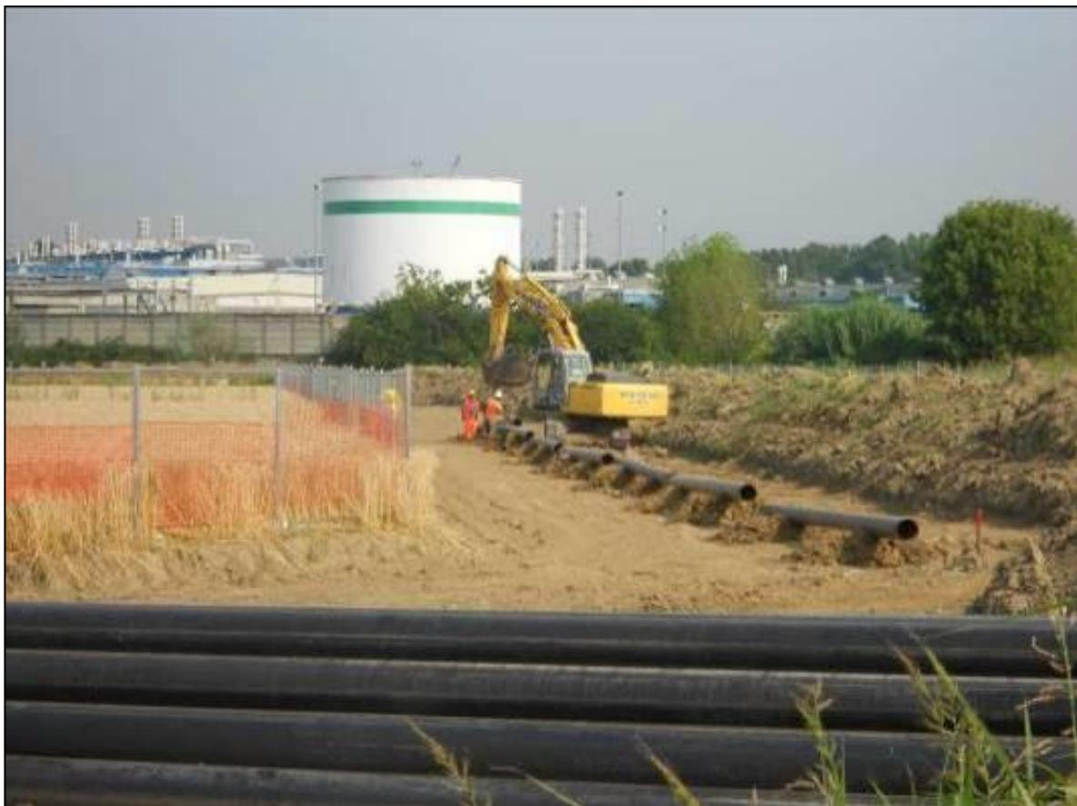
**Figura 7.1.4/A: Sfilamento tubi**
