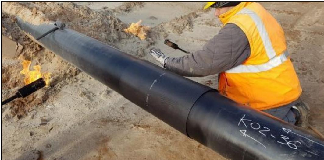
Figura 7.1.8/A – Applicazione manuale di una fascia termorestringente su giunto di saldatura
