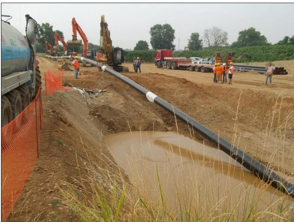
**Figura 7.1.12.1/C – Esempio di operazione di varo della TOC**
