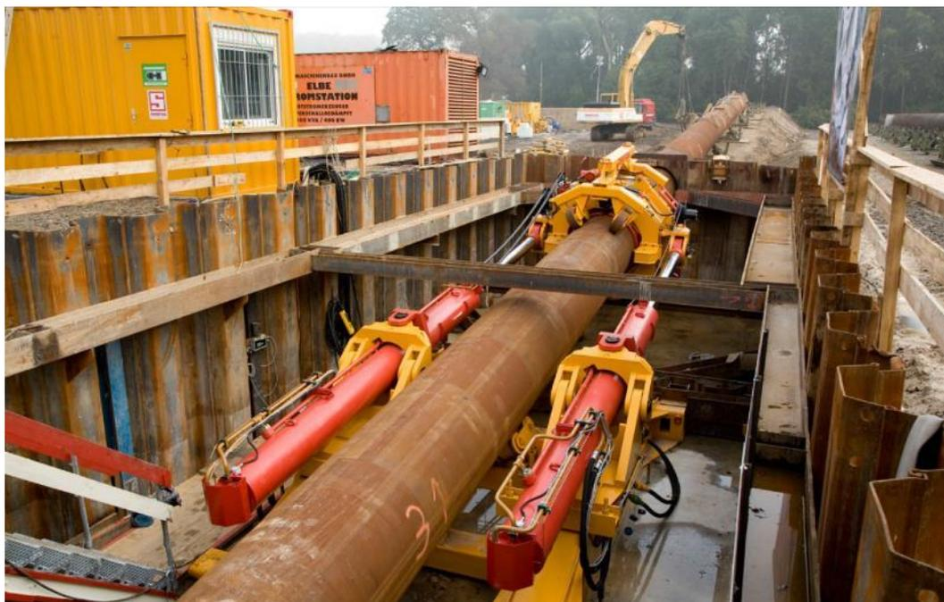
**Figura 7.1.12.3/B – Particolare della colonna di varo spinta tramite il pipe thruster**
