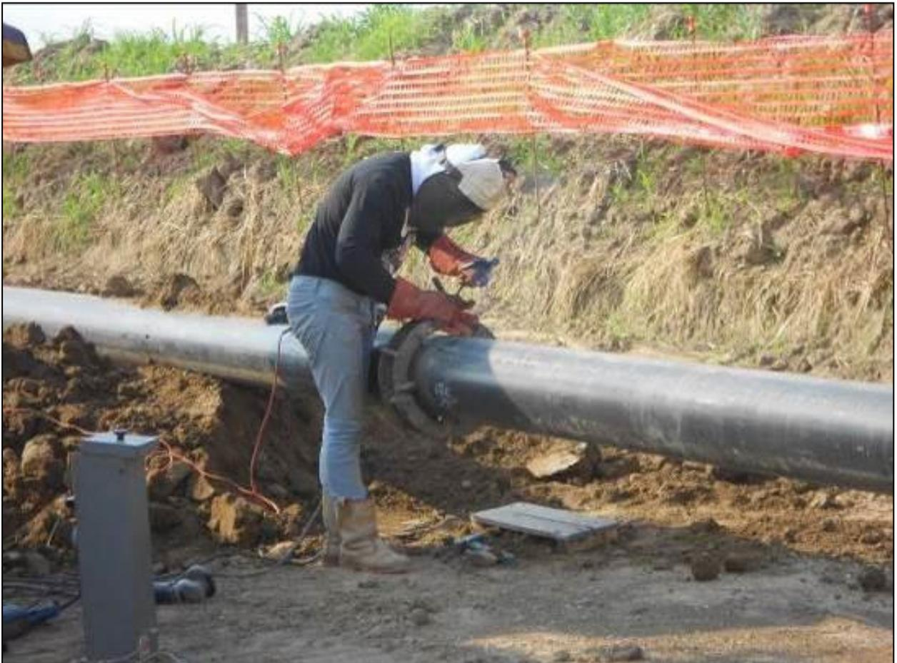
Figura 7.1.5/A: Saldatura della tubazione
