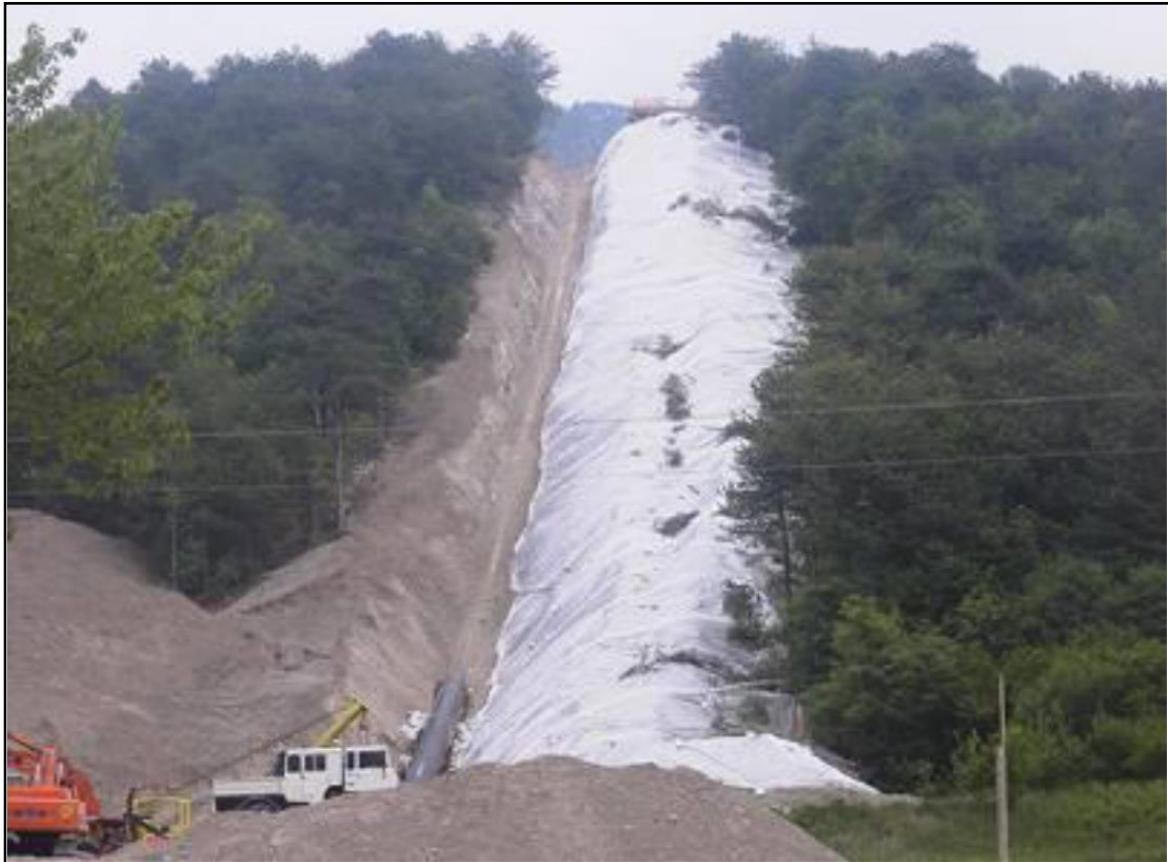
Figura 7.1.2/B - Esempio di fasi di lavoro in aree a pendenza longitudinale elevata
