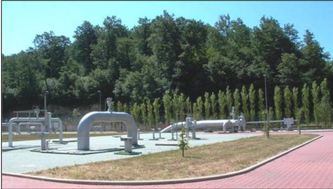
**Figura 6.2/A – Esempio di impianto di lancio e ricevimento “pig”**
