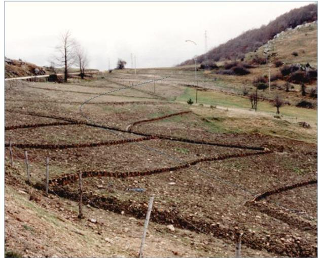
Figura 7.1.16.1/A– Schema ed esempio di fascinata
