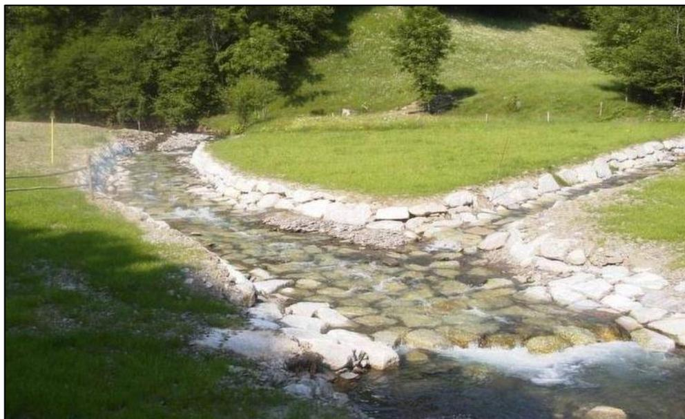
Figura 7.1.16.4/C – Esempio di rivestimento in massi e platea di fondo
