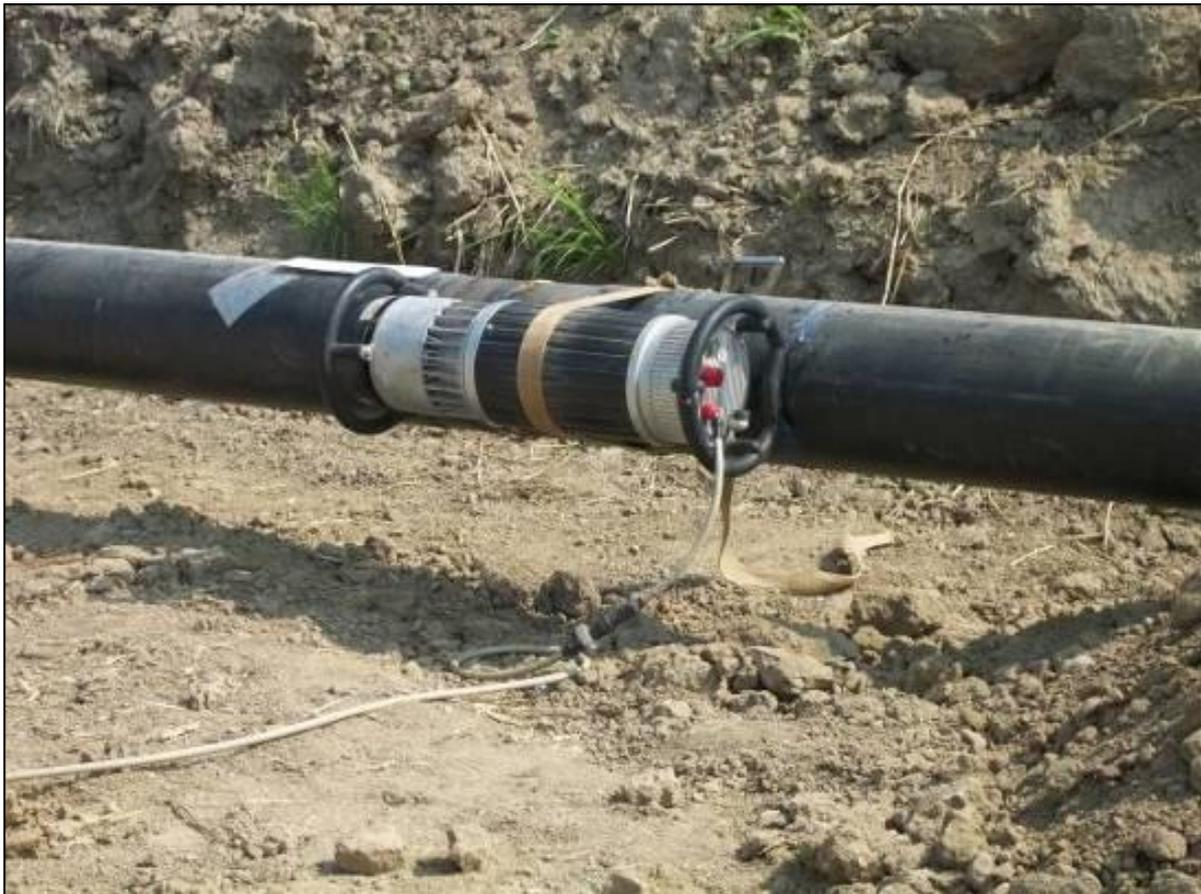
**Figura 7.1.6/A: Controlli non distruttivi delle saldature**
