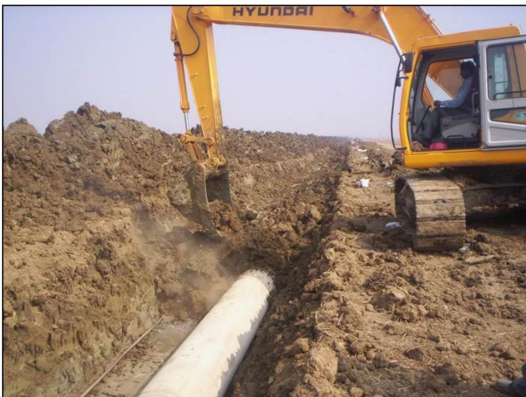
Figura 7.1.10/A - Rinterro della condotta
