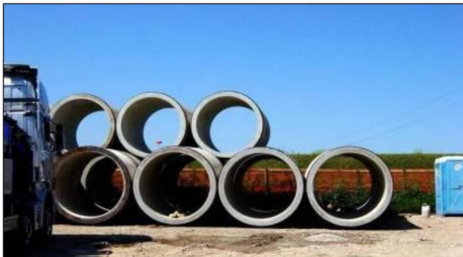
Figura 7.1.12.2/E – Stoccaggio tubi in c.a.
