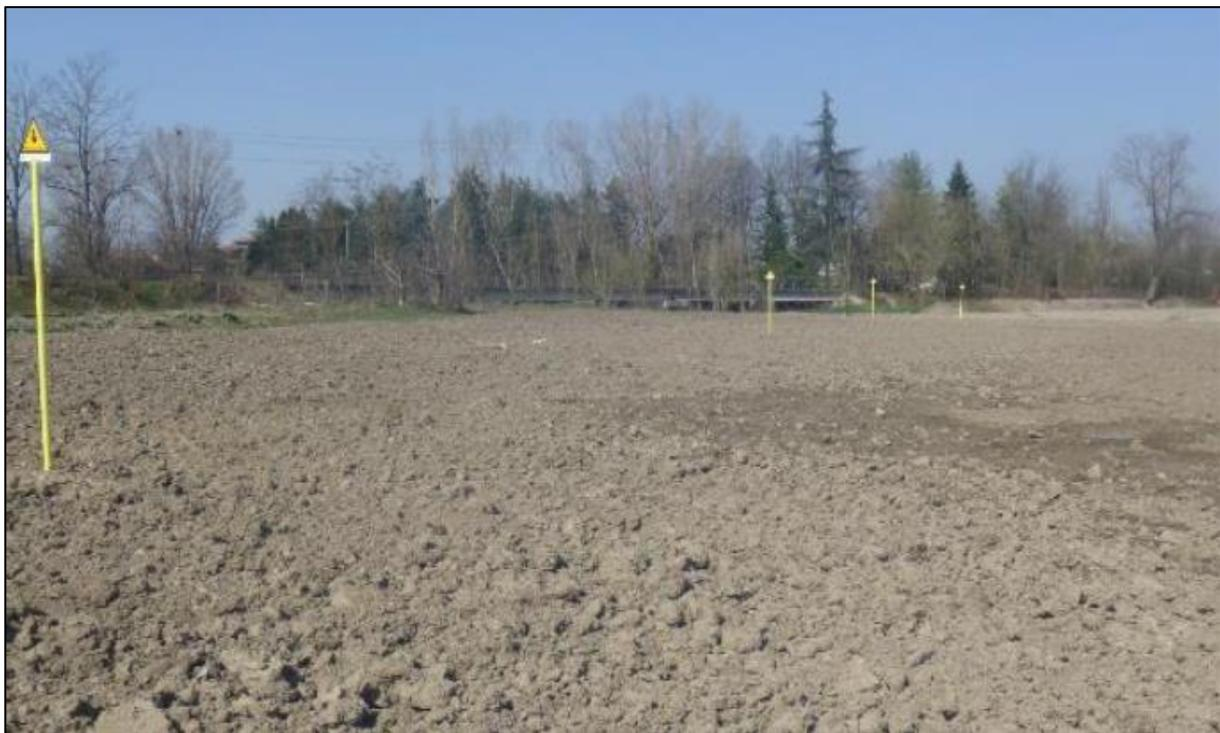
**Figura 7.1.15 – Pista lavori, su terreno agricolo, a ripristini ultimati; si nota la disposizione delle paline segnaletiche su metanodotto in esercizio**
