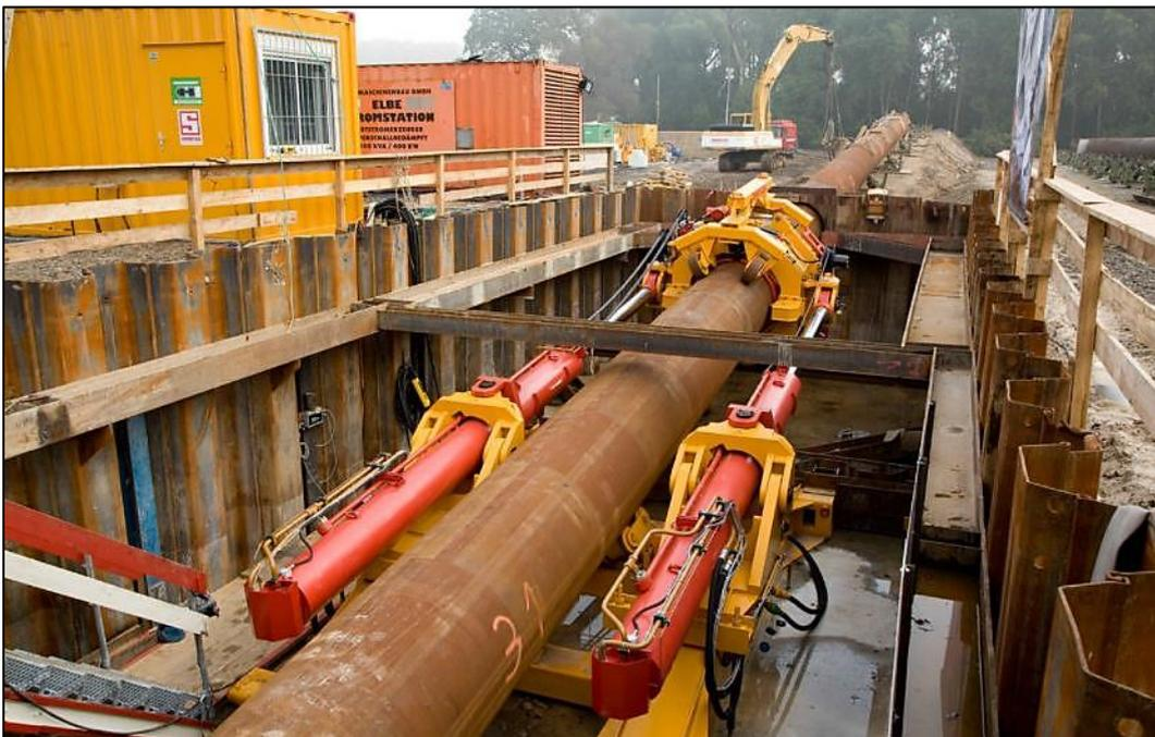
**Figura 7—XX: Particolare della colonna di varo spinta tramite il pipe thruster**
