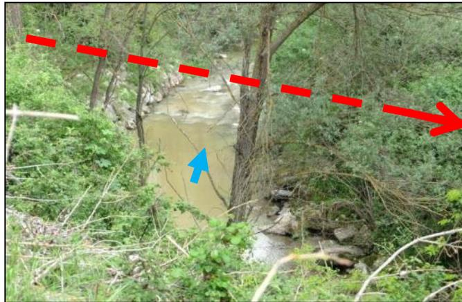
**Figura 7—V: Attraversamento T. Niccone con trenchless**
