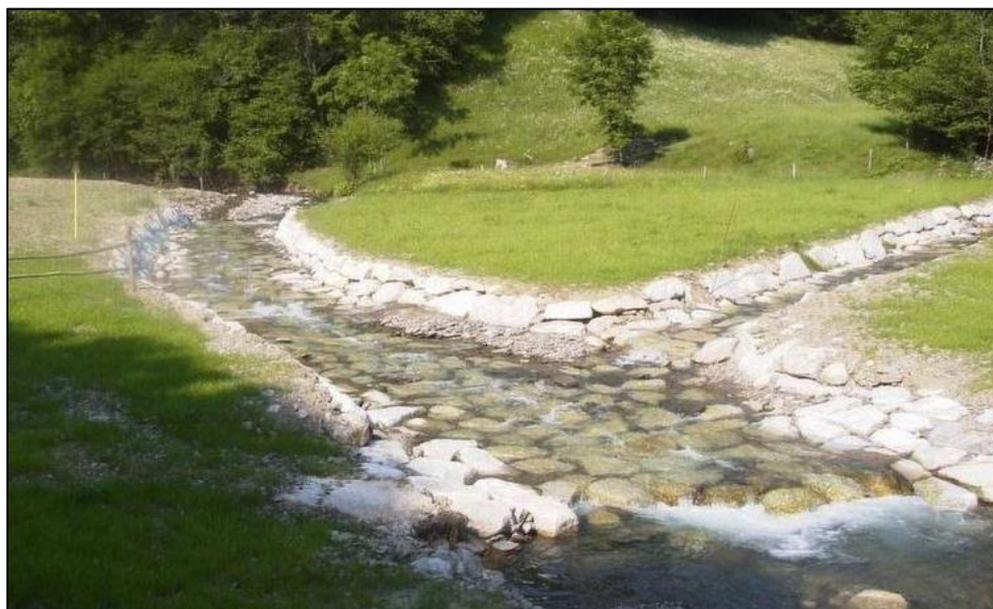
**Figura 7.4/C – Esempio di rivestimento in massi con platea di fondo**
