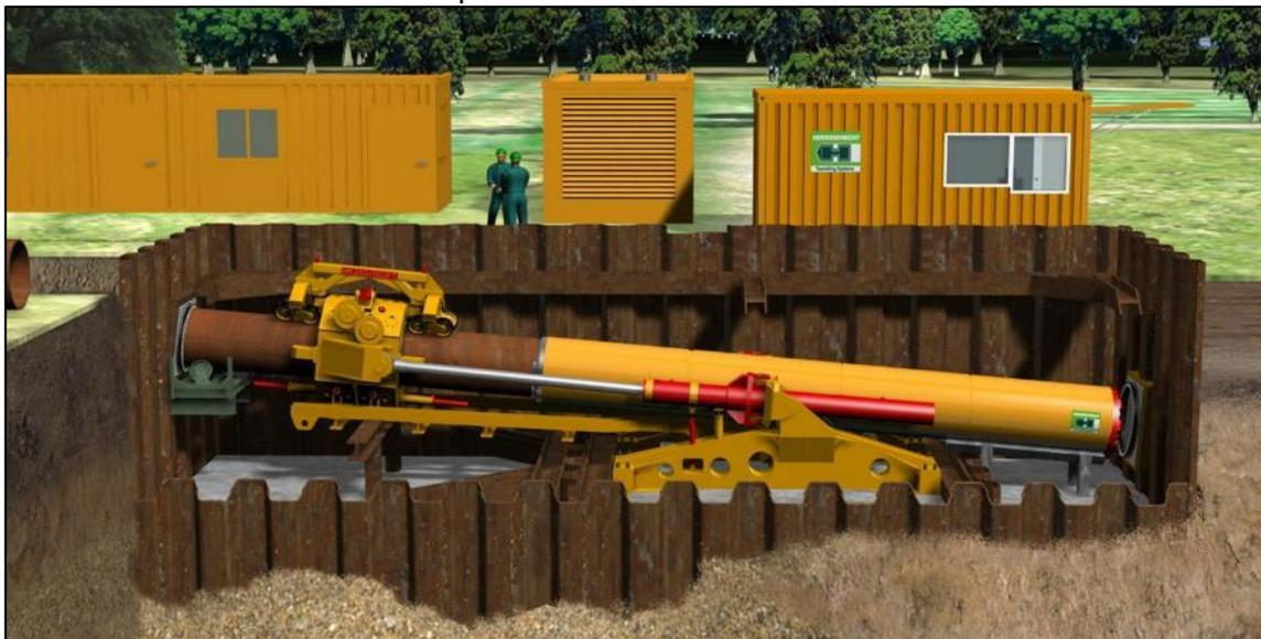
Figura 7.5.2/C – Particolare della colonna di varo spinta tramite il pipe thruster
