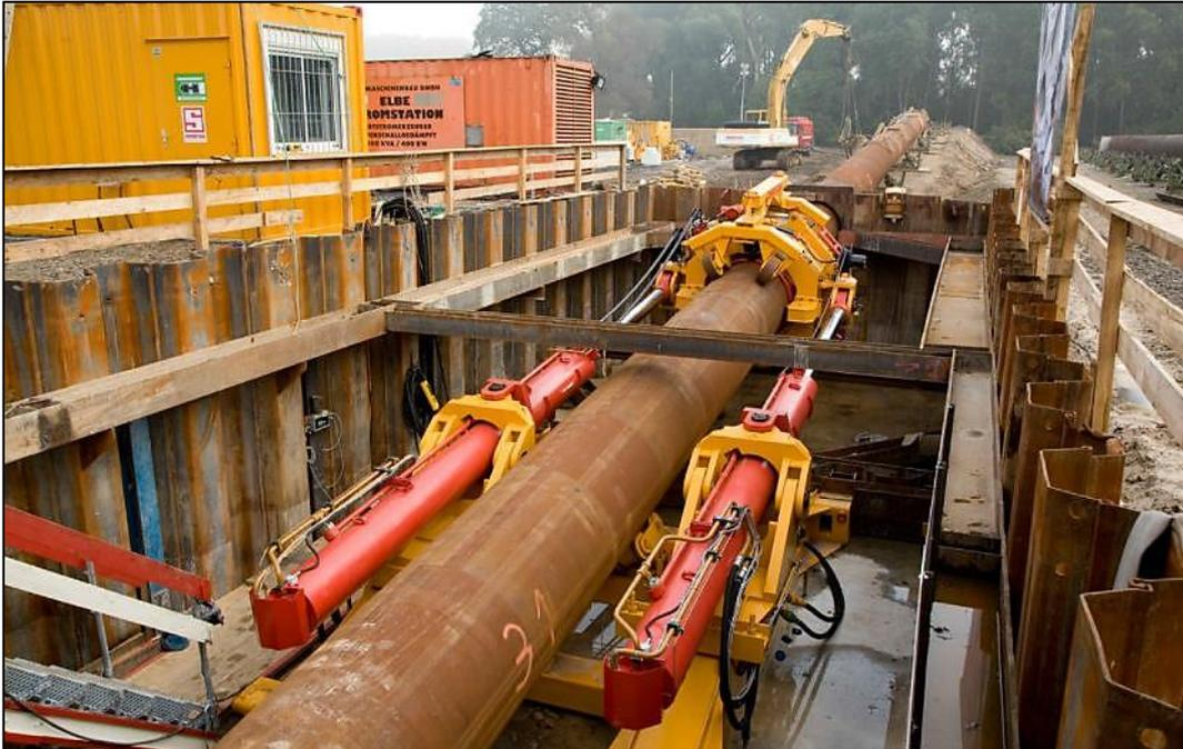
Figura 7.5.2/B – Particolare della colonna di varo spinta tramite il pipe thruster
