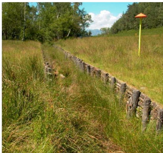
**Figura 7.2/D – Schema ed esempio di palizzata**
