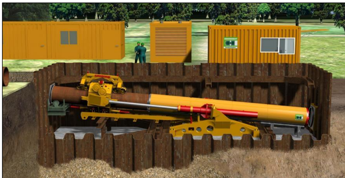
Figura 5.1.3/C – Particolare della colonna di varo spinta tramite il pipe thruster
