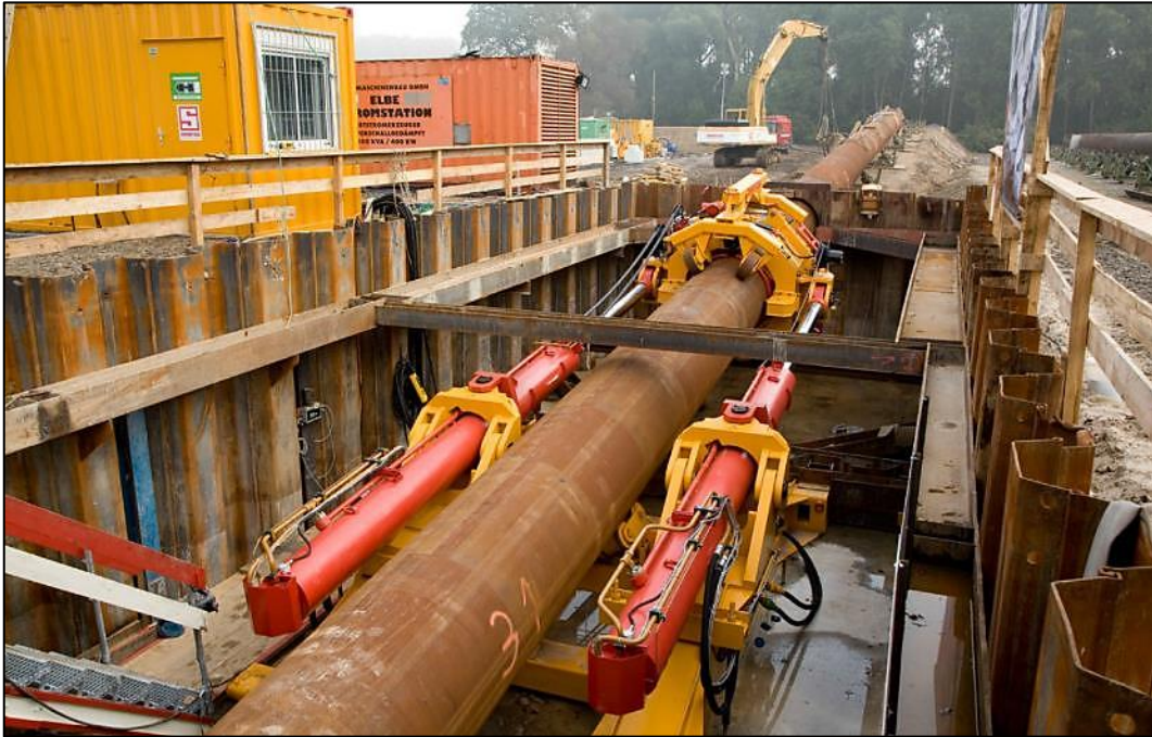
Figura 5.1.3/B – Particolare della colonna di varo spinta tramite il pipe thruster
