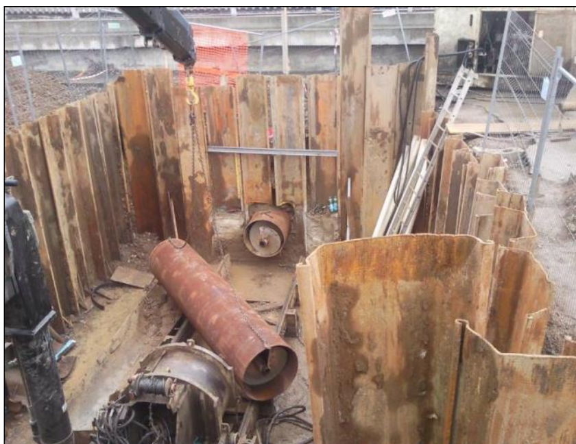
Fig. 5.1.4/B – Buca di spinta per trivella spingitubo sostenuta da palancoato
