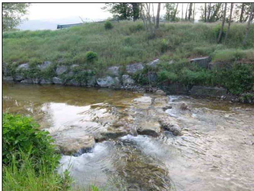
Figura 3.1/F – Opere di protezione poco a monte della sezione di attraversamento a protezione del metanodotto esistente
