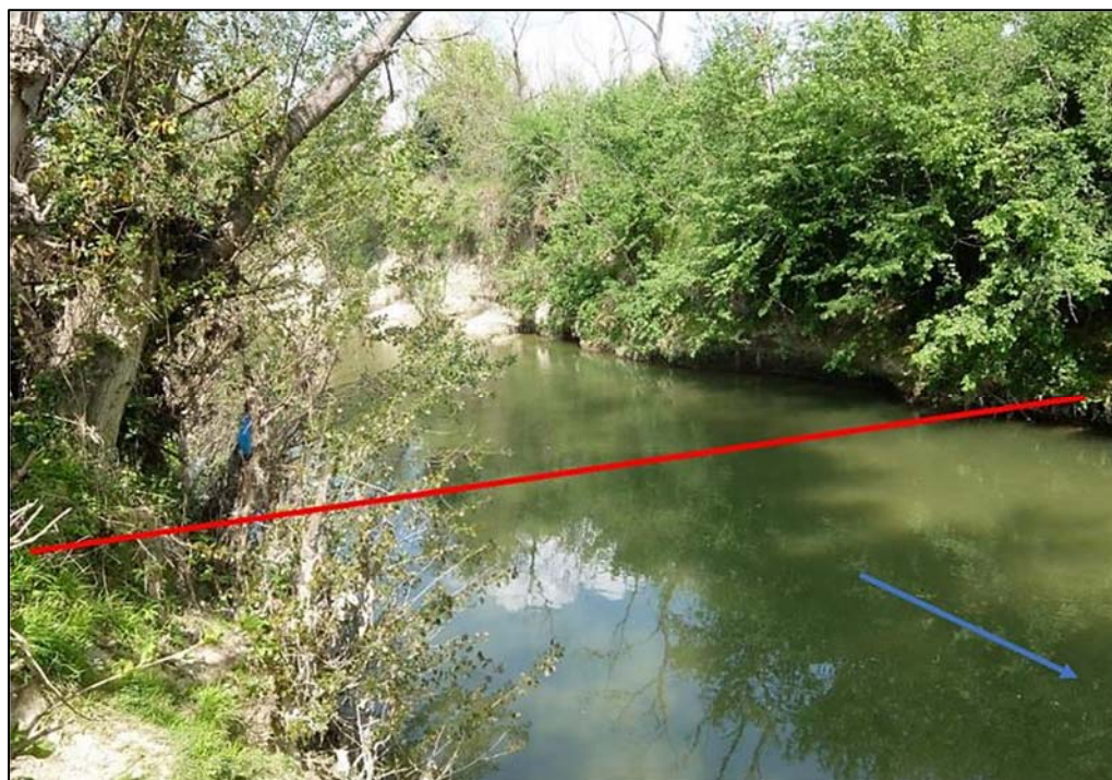
Figura 3.1/E – Foto della sezione di attraversamento, ripresa dalla sponda sinistra
