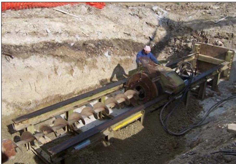
Fig. 5.2/A – Trivella ad elica con spingitubo
