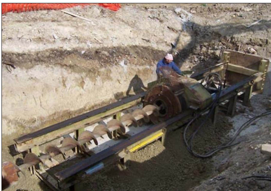
Fig. 5.2/A – Trivella ad elica con spingitubo
