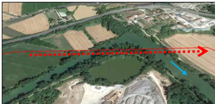
Figura 18 Attraversamento trenchless F. Tevere 5
