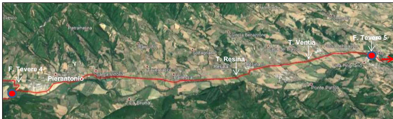
Figura 17 Vista aerea 3D del tratto in esame (da Google Earth)
