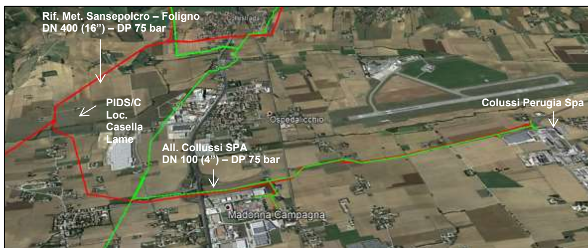
Figura 23 Vista aerea 3D del tracciato in esame (da Google Earth)
