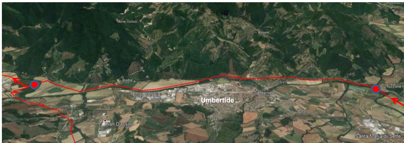
Figura 13 Vista aerea 3D del tratto in esame (da Google Earth)
