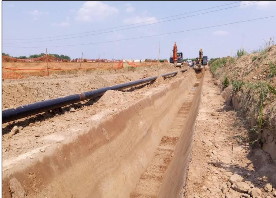
**Figura 2-12: Foto tipica di scavo della trincea**
