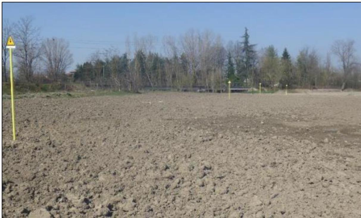
**Figura 2-23: Pista lavori, su terreno agricolo, a ripristini ultimati; si nota la disposizione delle paline segnaletiche su metanodotto in esercizio**
