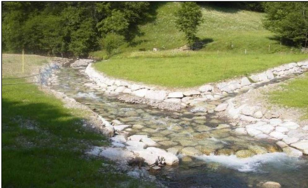
**Figura 5-11: Esempio di rivestimento in massi e platea di fondo**
