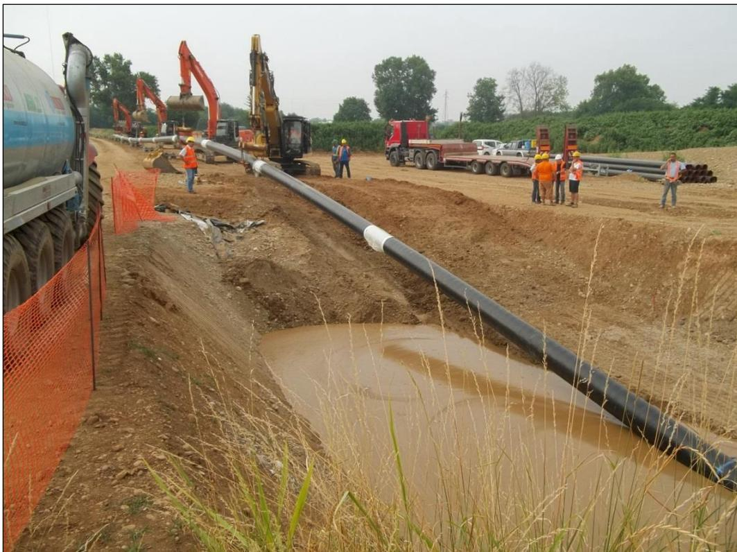
**Figura 2-20: Esempio di operazione di varo della TOC**
