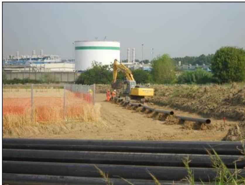
**Fig. 5/C: Sfilamento tubi**
