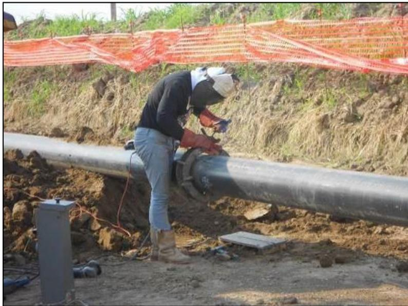
Fig. 5/D: Saldatura delle tubazioni
