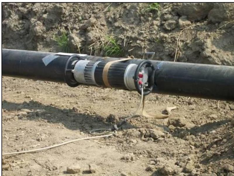
Fig. 5/E: Controlli non distruttivi delle saldature
