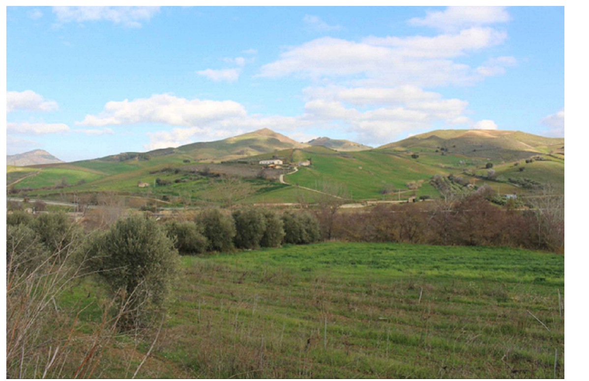
Vista panoramica dell'imbocco della galleria ripresa da sud
