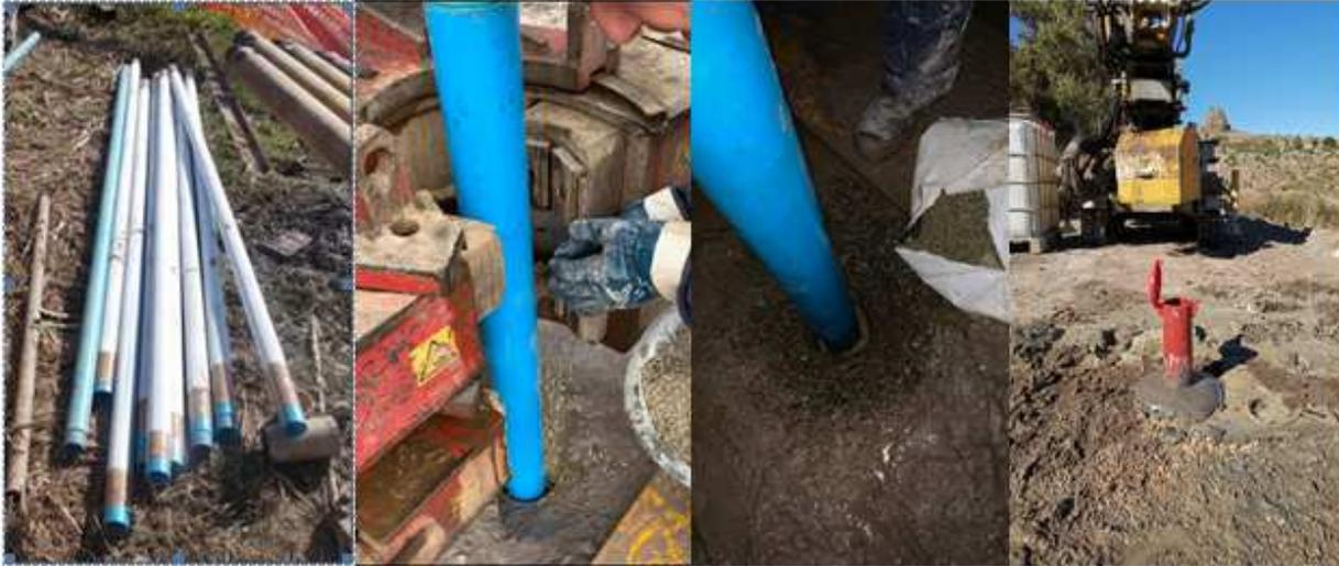
Foto 4– Installazione tubi piezometrici da 3”
