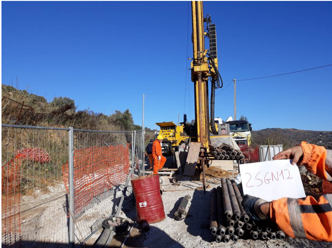
2SGN12BIS: Postazione sondaggio in corso
