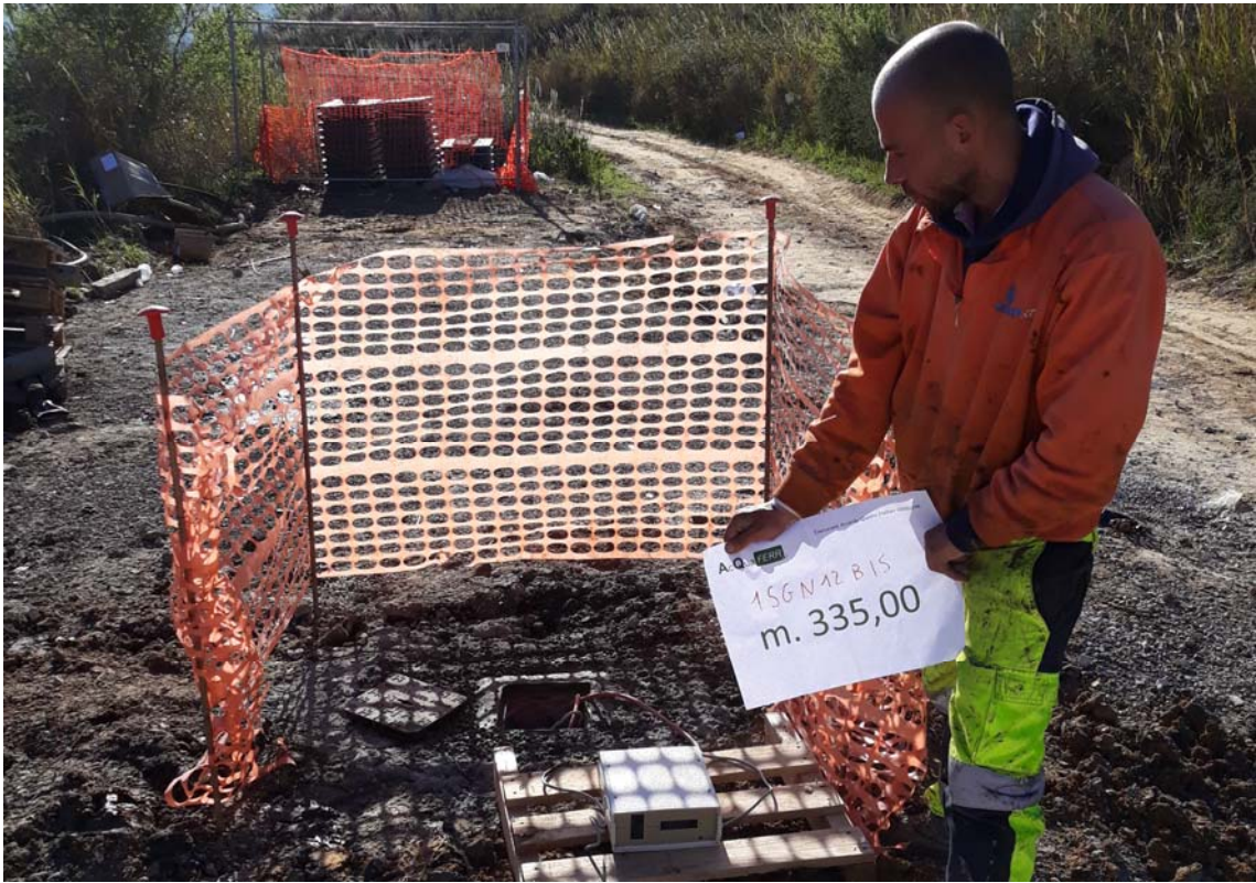
2SGN12BIS: Fasi installazione Piezometro Corda Vibrante
