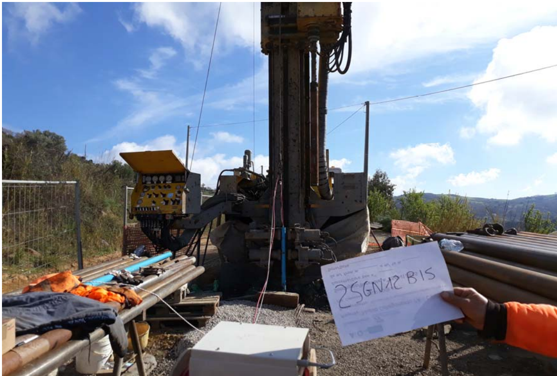
2SGN12BIS: Fasi installazione Piezometro Corda Vibrante
