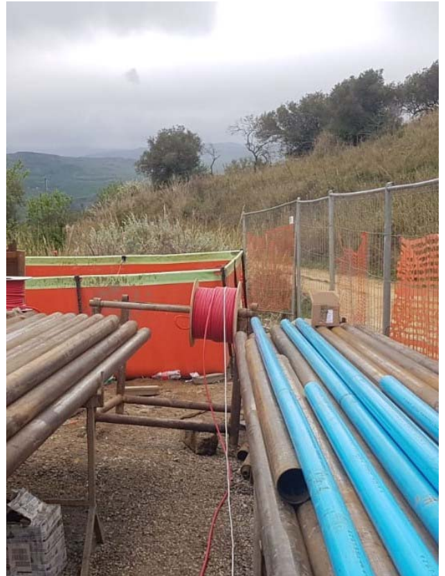
2SGN12BIS: Fasi installazione Piezometro Corda Vibrante
