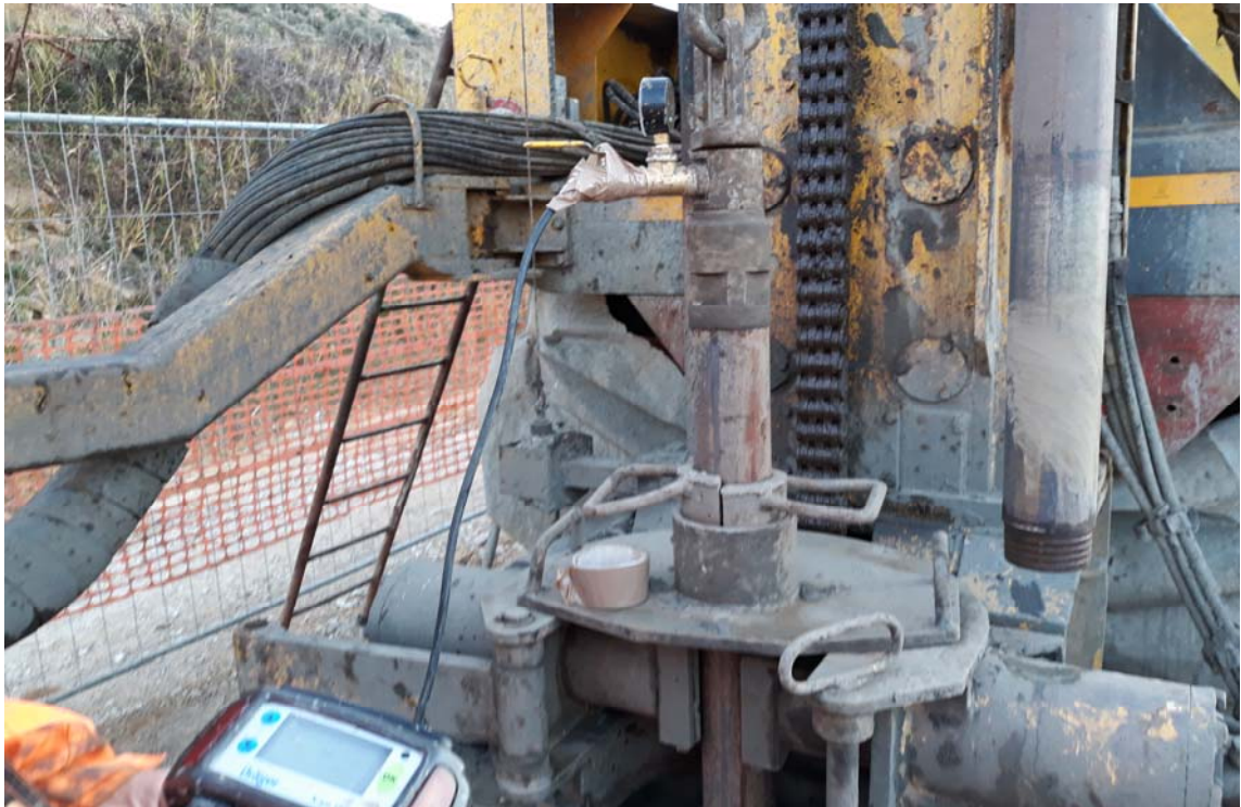
2SGN12BIS: Installazione rubinetto e manometro per misurazione GAS
