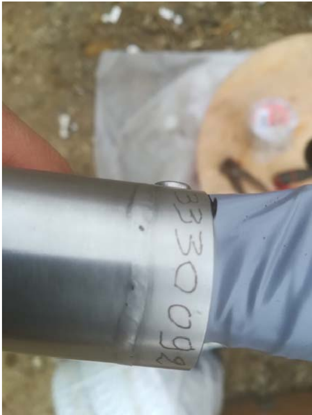
2SGN12BIS: Fasi installazione Piezometro Corda Vibrante
