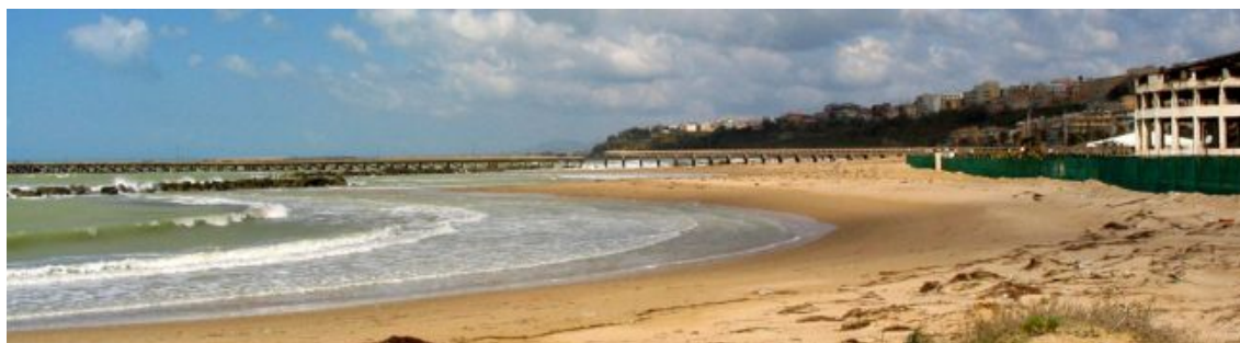
Figura 3.2/9. Vista del pontile sbarcatoio
