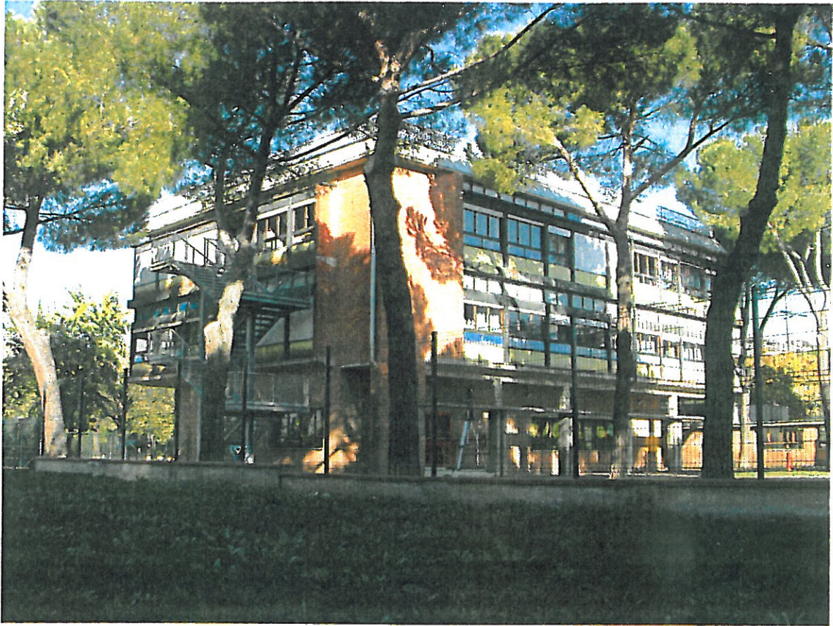
Scuola "Collodi" - Vista in direzione della scuola
