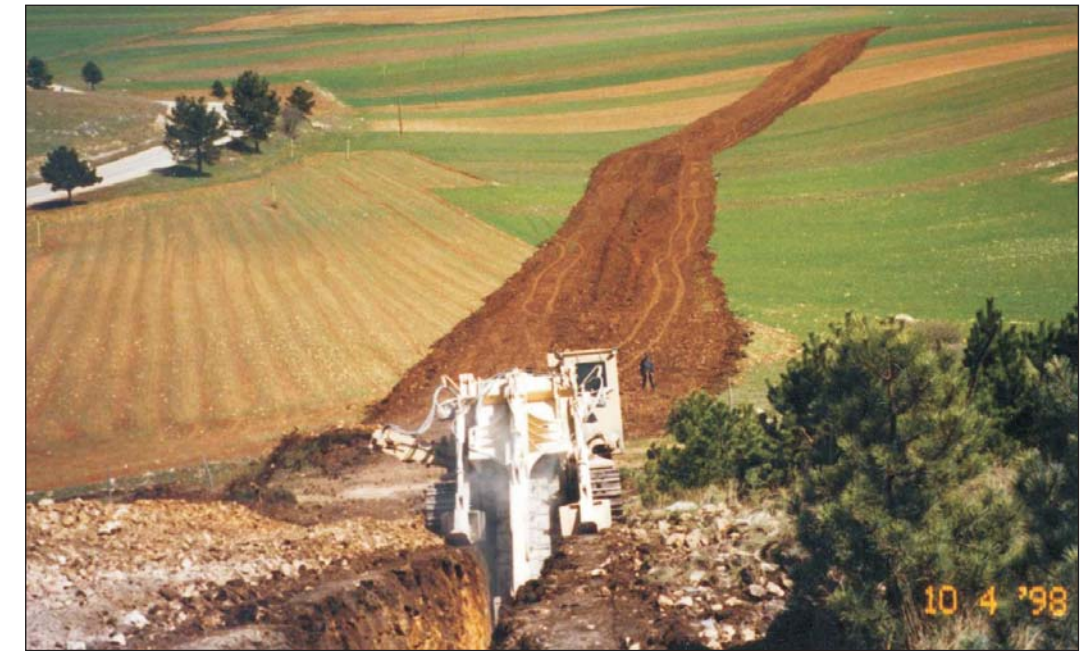
SCAVO DELLA TRINCEA
