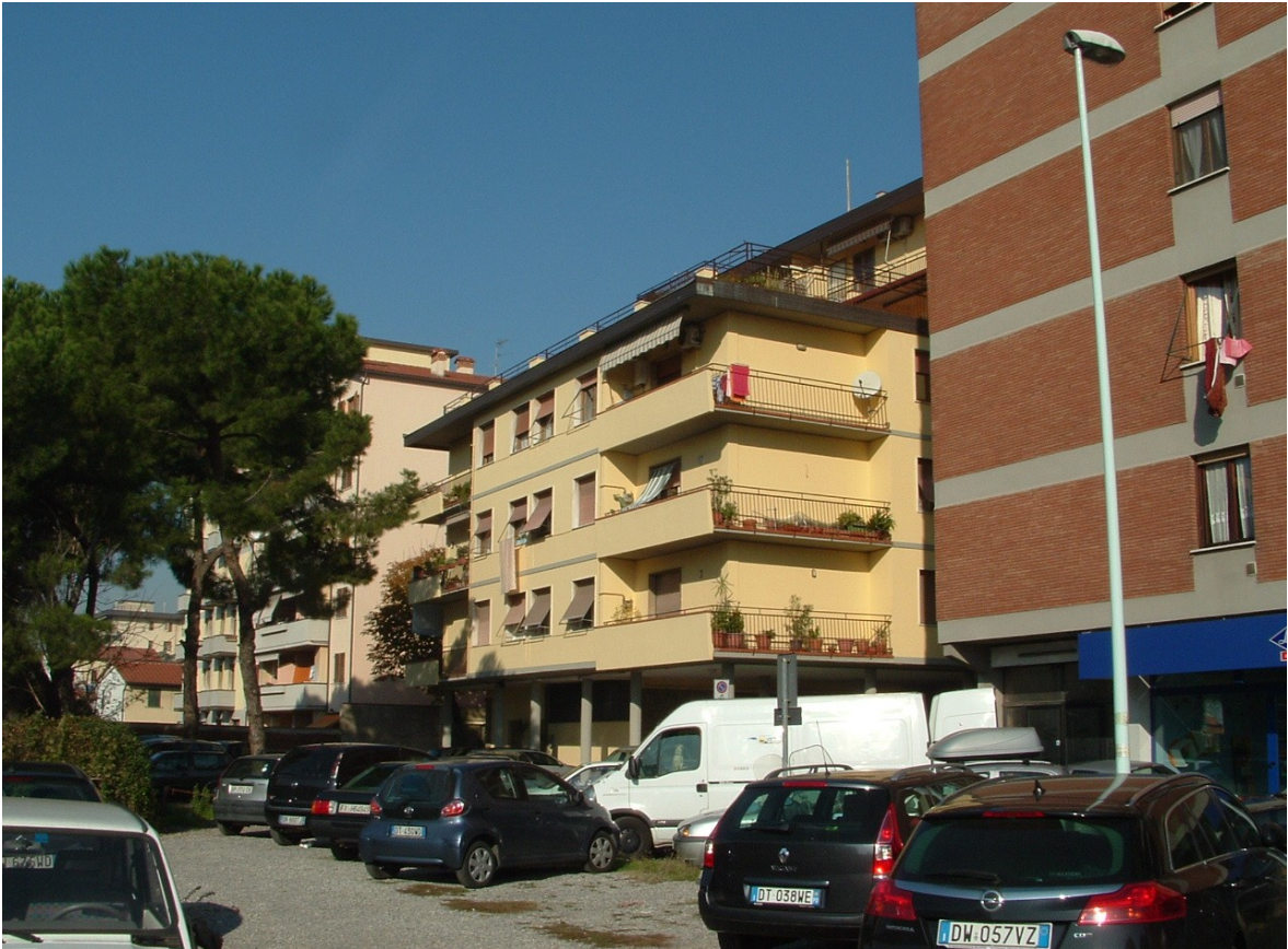
Condominio Via Milano (giallo)
