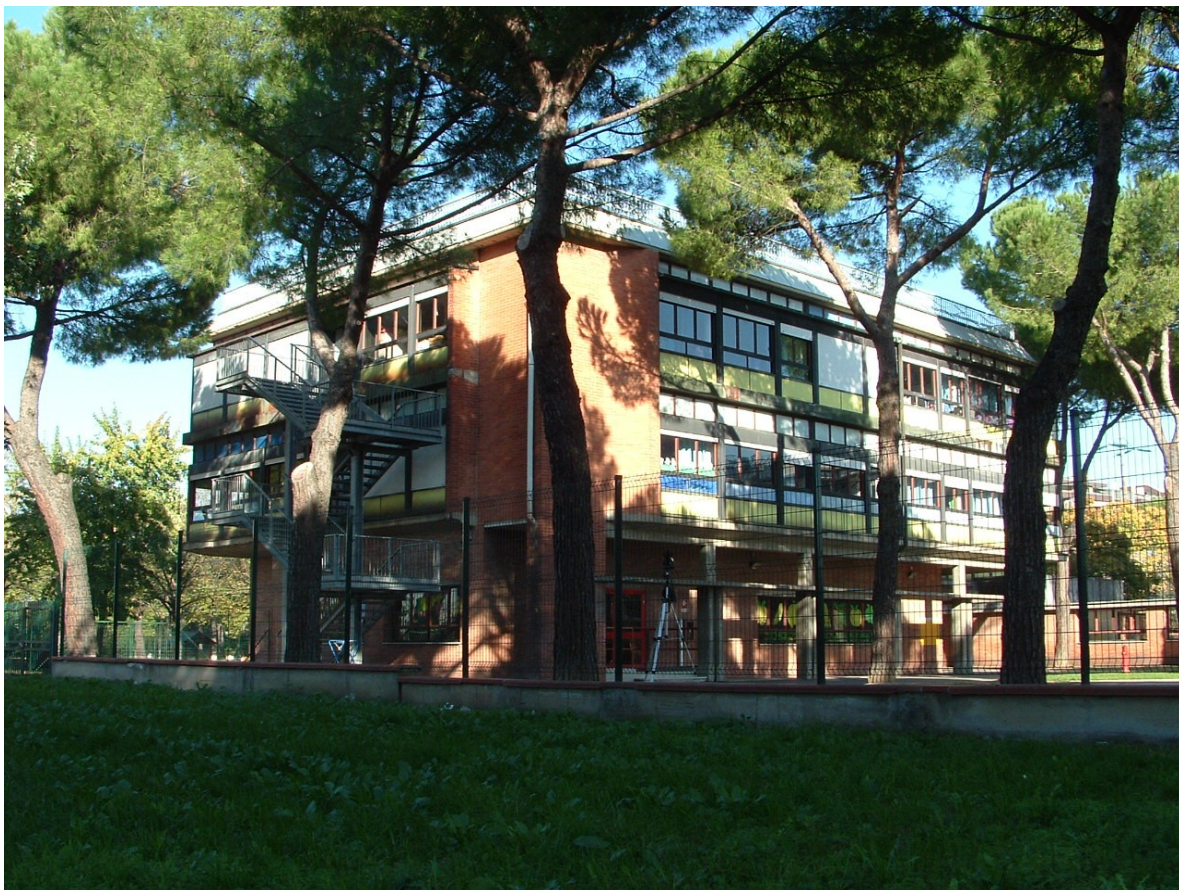
Scuola "Collodi" - Vista in direzione della scuola
