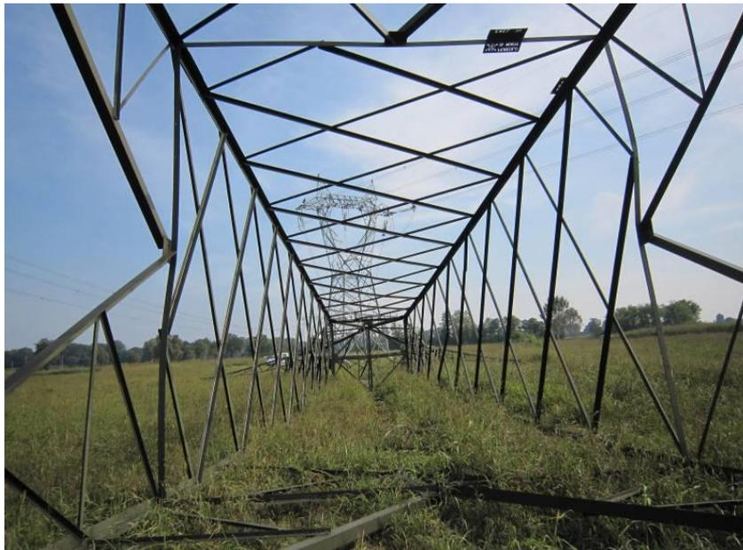
Figura 4.4/1 - Fasi demolizione di un sostegno a traliccio
