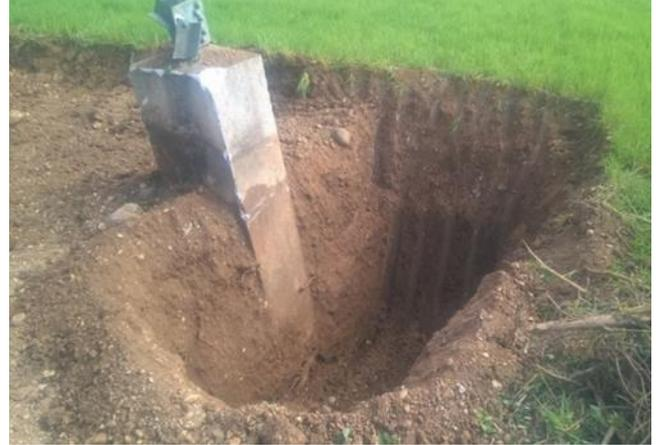
Figura 4.4/3 - Esempio di rimozione della fondazione superficiale di un sostegno 220 kV (a sx) e 380 kV ST (a dx).
